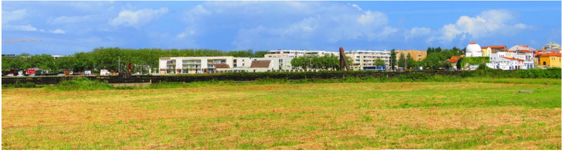
Figura 51_Vista A (este-oeste)
