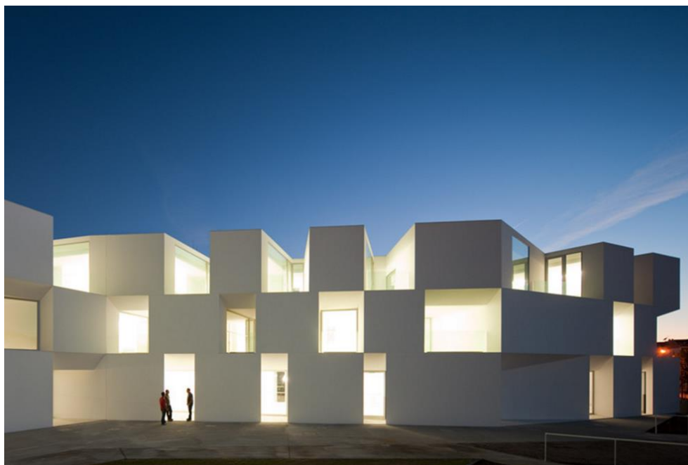
Figura 21_Residências Assistidas em Alcácer, Arq. Aires Mateus, Portugal
