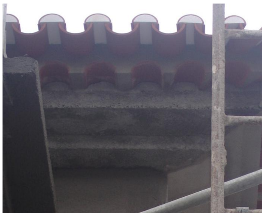
Foto 5.11 - Pormenor da cobertura, Castelo Branco
