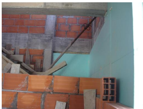
Foto 5.45 - Pormenor construtivo da zona do pilar, Sabugal
