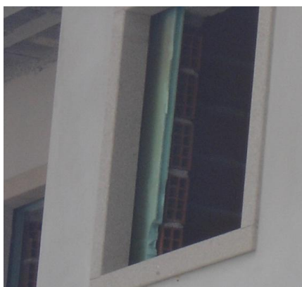
Foto 5.16 - Pormenor da correcção de pontes térmicas planas, Figueira de Castelo Rodrigo
