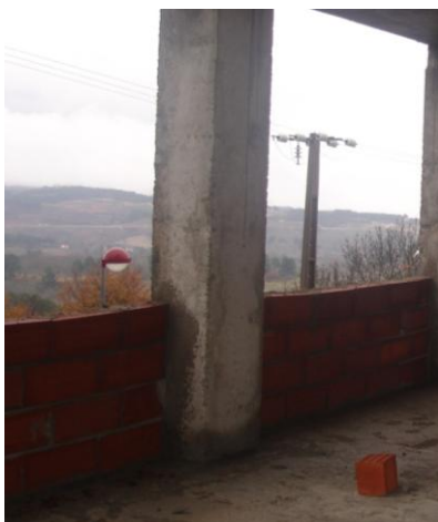
Foto 5.47 - Pormenor construtivo da zona do pilar, Trancoso
