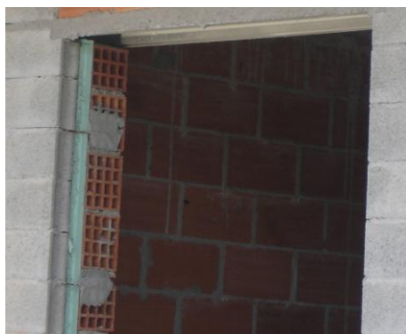
Foto 5.37 - Pormenor construtivo das paredes exteriores, Meda
