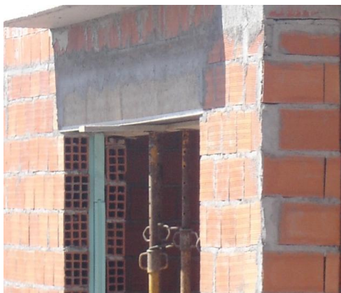
Foto 5.5 - Pormenor das paredes exteriores, Belmonte
