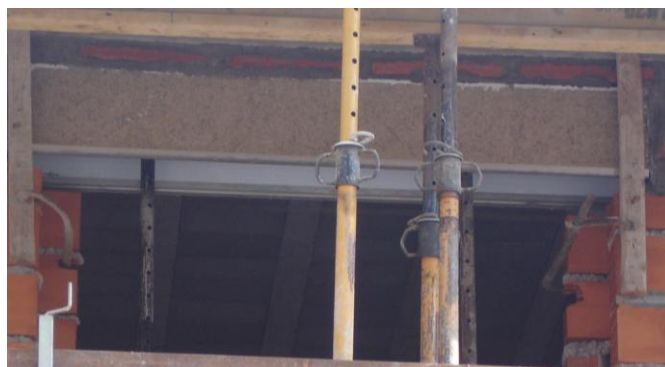
Foto 5.39 - Pormenor construtivo caixa de estore, Penamacor
