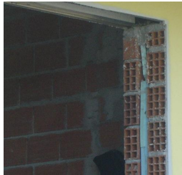
Foto 5.22 - Pormenor construtivo das paredes exteriores, Fundão
