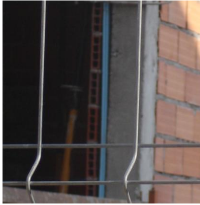
Foto 5.40 - Pormenor construtivo da ponte térmica plana na zona do pilar, Penamacor
