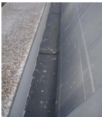
Foto 5.30 - Pormenores construtivos da cobertura inclinada, Guarda
