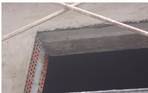
Foto 5.10 - Fechamento de paredes, Castelo Branco
