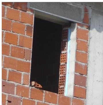
Foto 5.33 - Pormenor construtivo das paredes exteriores, Idanha-a-Nova
