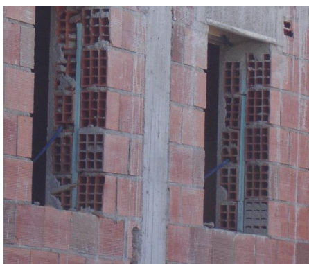
Foto 5.24 - Pormenor construtivo das paredes exteriores, Gouveia
