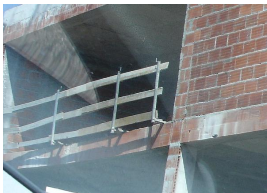
Foto 5.8 - Pormenor do talão da viga, Belmonte
