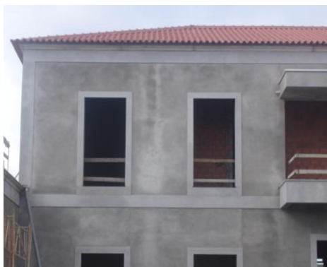
Foto 5.1 - Vista geral da fase da obra em Almeida
