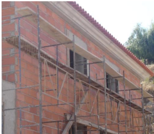
Foto 5.14 - Pormenor da correcção de pontes térmicas planas, Celorico da Beira
