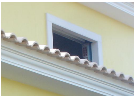
Foto 5.23 - Pormenor construtivo caixa de estore, Fundão
