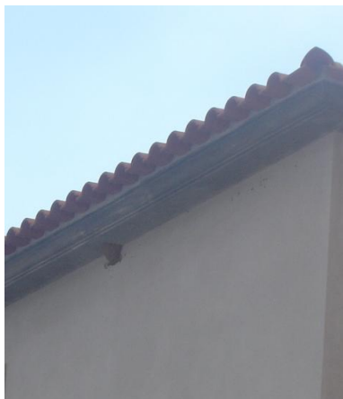
Foto 5.18 - Pormenor da cobertura, Figueira de Castelo Rodrigo
