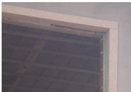
Foto 5.17 - Pormenor de abertura do vão envidraçado, Figueira de Castelo Rodrigo
