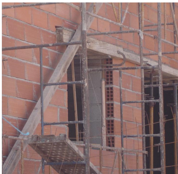
Foto 5.12 - Pormenor das paredes exteriores, Celorico da Beira
