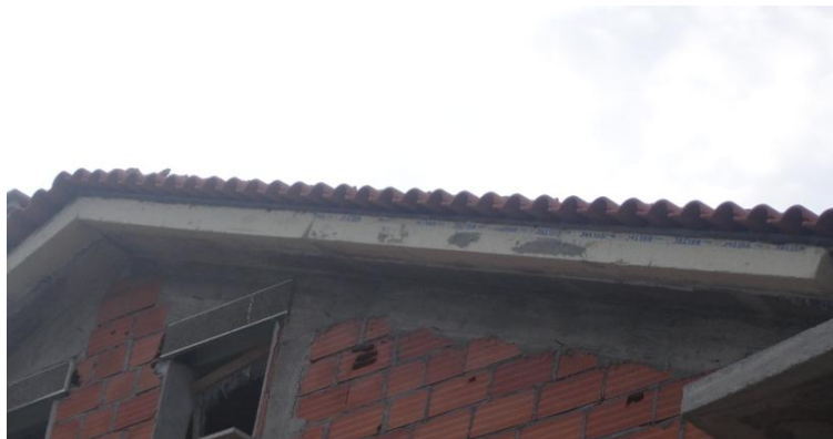
Foto 5.50 - Pormenor construtivo da cobertura, Vila Velha de Ródão
