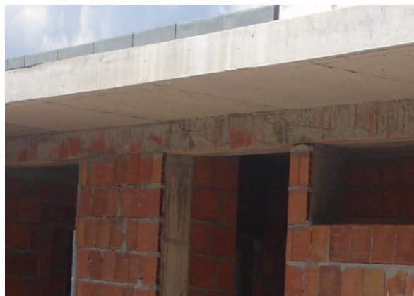
Foto 5.7 - Pormenor da zona de pilar, Belmonte
