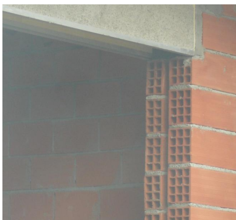
Foto 5.49 - Pormenor construtivo das paredes exteriores, Vila Velha de Ródão
