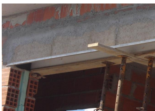
Foto 5.9 - Pormenor da caixa de estore, Belmonte
