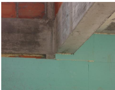
Foto 5.44 - Pormenor construtivo do talão da viga, Sabugal
