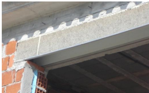
Foto 5.34 - Pormenor construtivo caixa de estore, Idanha-a-Nova
