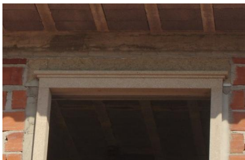
Foto 5.42 - Pormenor construtivo da abertura dos vãos envidraçados, Pinhel
