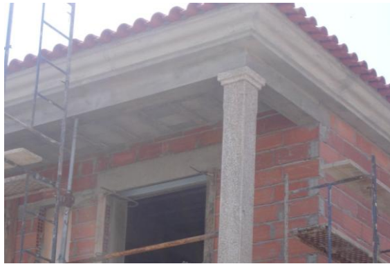
Foto 5.13 - Pormenor da laje de cobertura, Celorico da Beira
