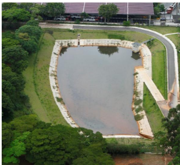
Figura 3.6 - Bacia de retenção para AEE
