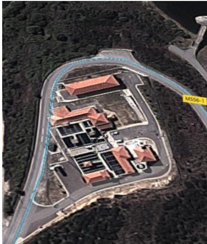
Figura 4.1 - Vista aérea da ETA do Caldeirão
