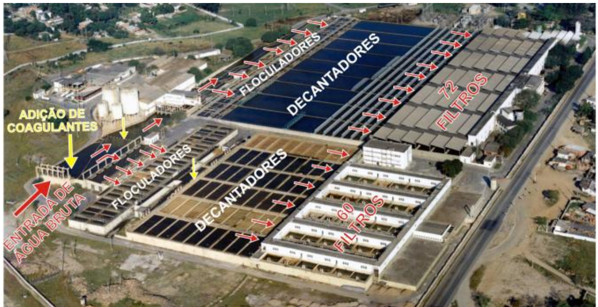
Figura 2.1 - Fotografia aérea da ETA de Guandu
