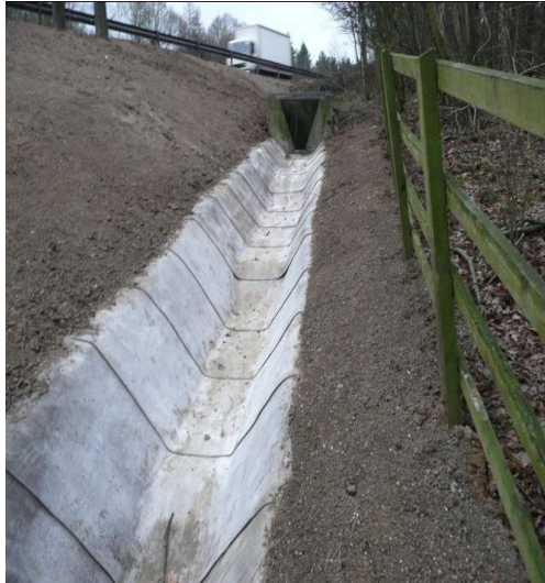
Figura 3.1 - Valeta para recolha de águas pluviais
