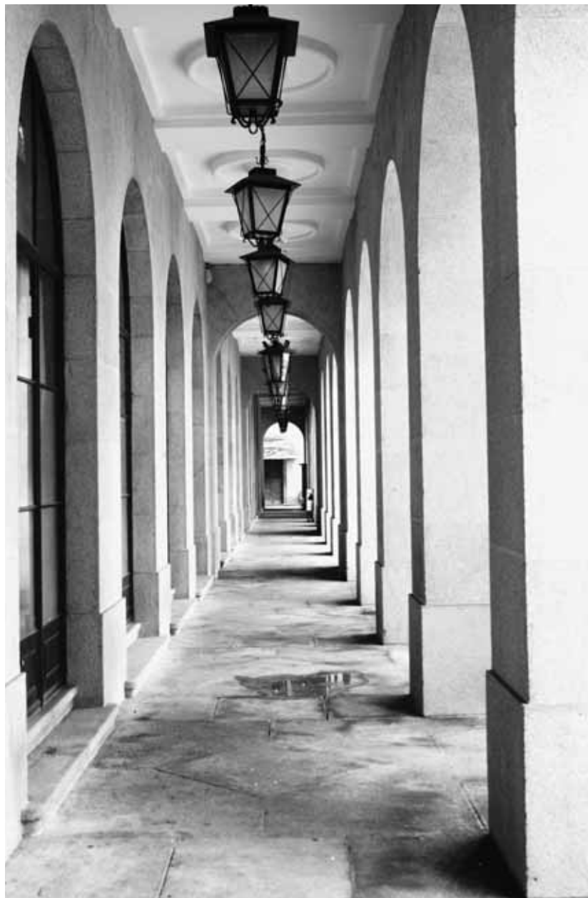
Figura 25 - Arcadas da Câmara Municipal da Covilhã | Covilhã
