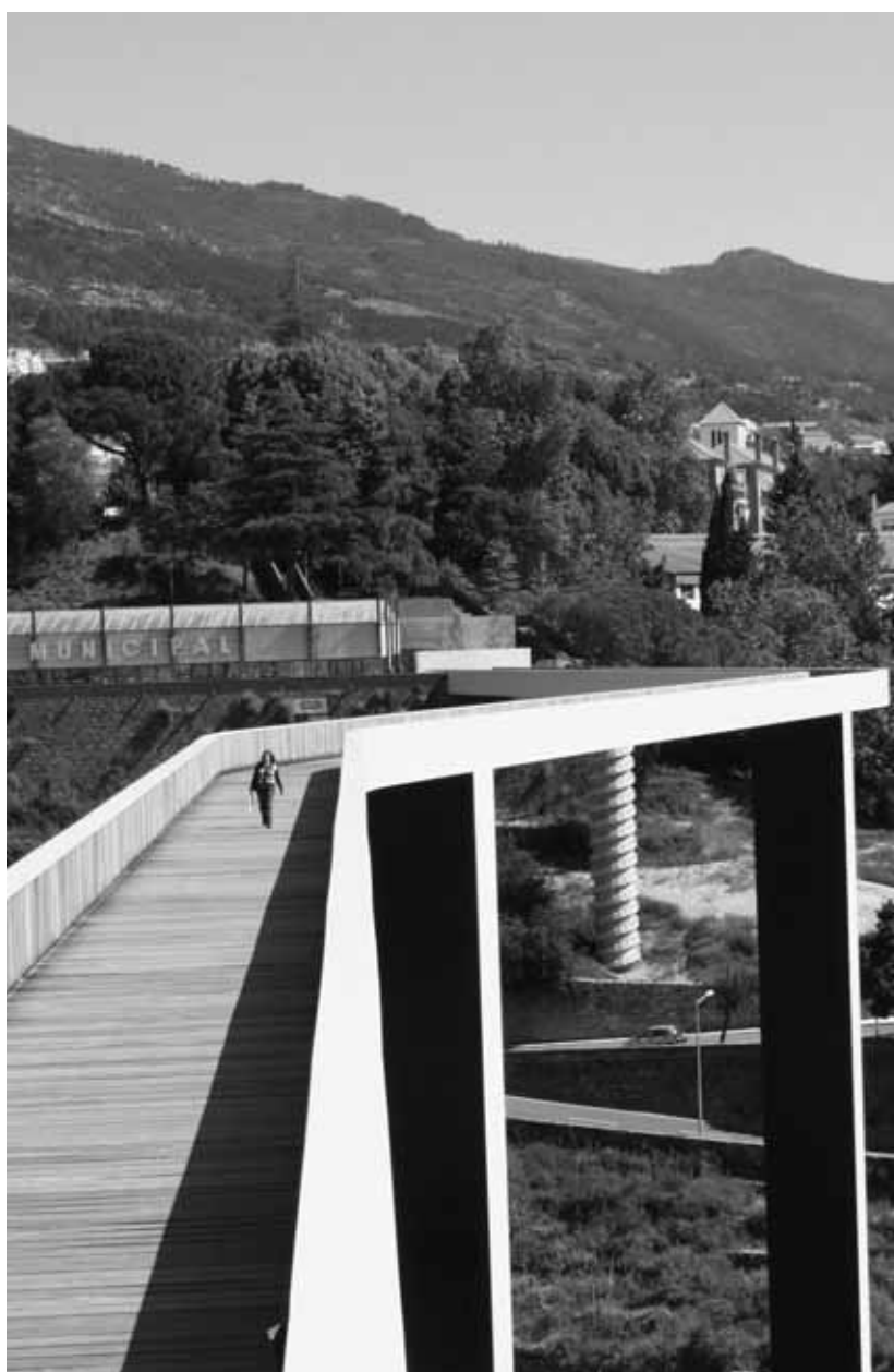
Figura 31 - Ponte pedonal - Projecto do Arquitecto Carrilho da Graça | Covilhã
