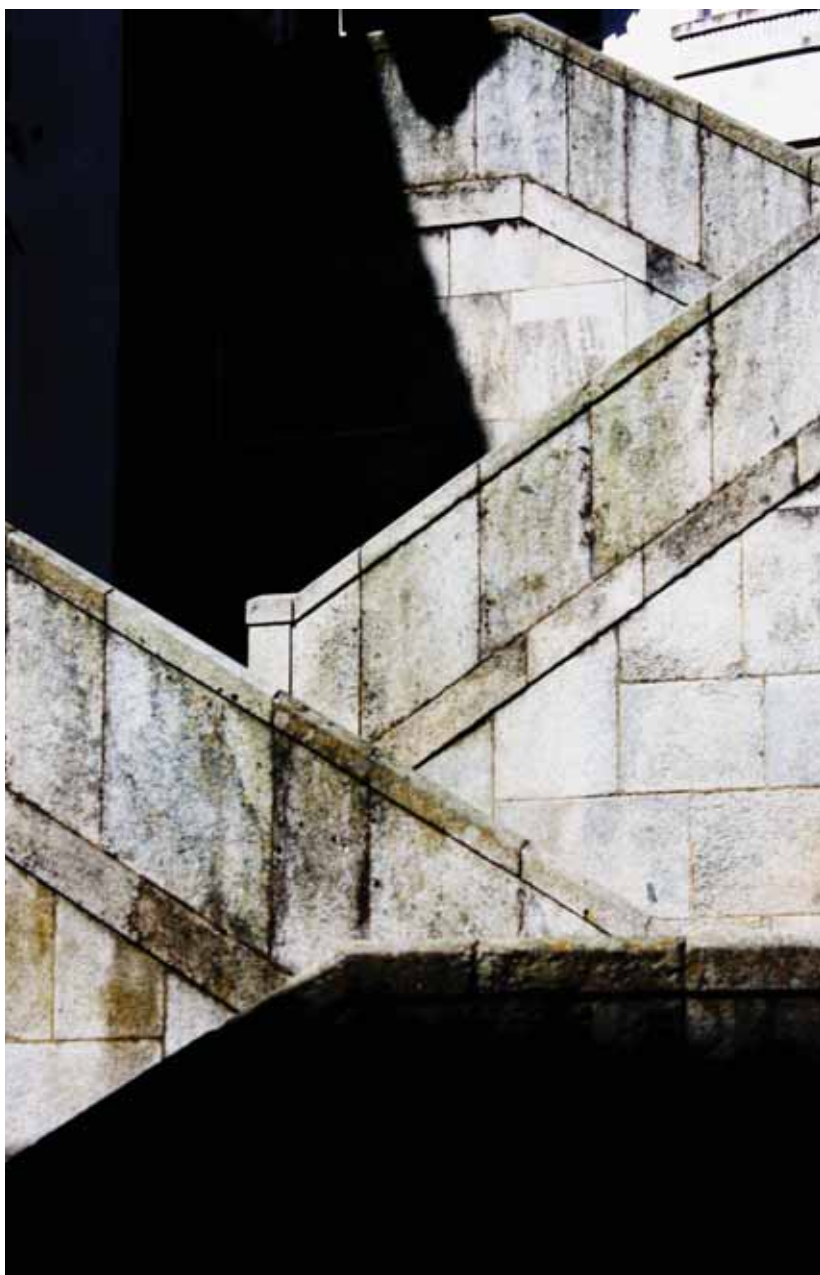
Figura 21 - Escadaria de ligação à Rua Direita - Cidade da Covilhã | Covilhã
