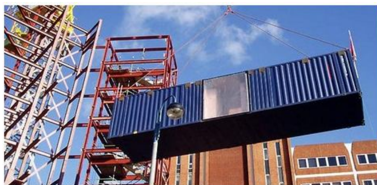
Figura 2.16 - Hotel em Uxbridge, Inglaterra – montagem dos contentores [E]
