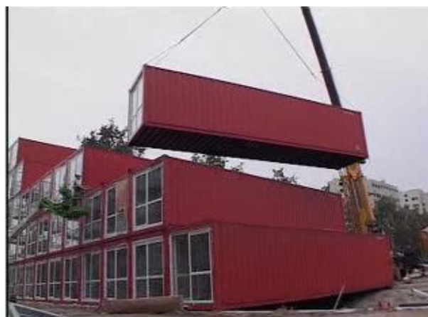
Figura 2.6 - Assemblagem dos contentores [U]
