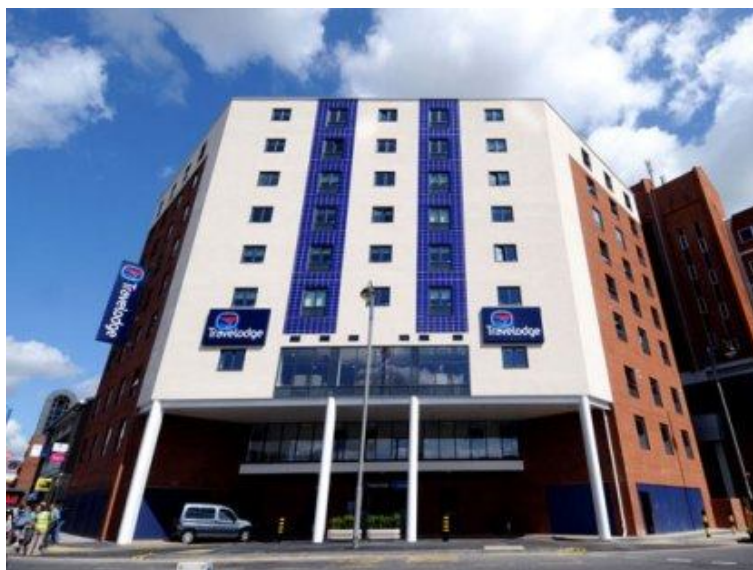
Figura 2.17 - Hotel em Uxbridge (obra acabada) [D]
