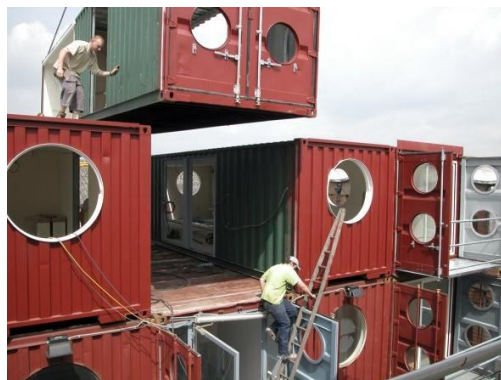
Figura 2.2 - Construção de Container City [T]
