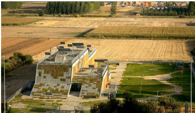
Figura 22: Vista geral da Implantação das Residências Assistidas de Camarzana de Tera : (Fonte: http://www.electicos.com/residencia-ancianos-zamora-por-javier-de-anton/ )
