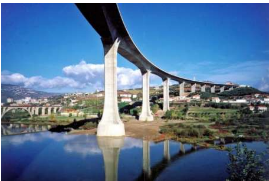
Figura 1.21- Ponte rodoviária Miguel Torga sobre o rio Douro inserida na A24 [36]
