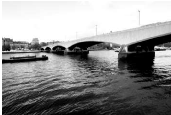
Figura 1.1- Vista geral da Ponte de Waterloo [37]
