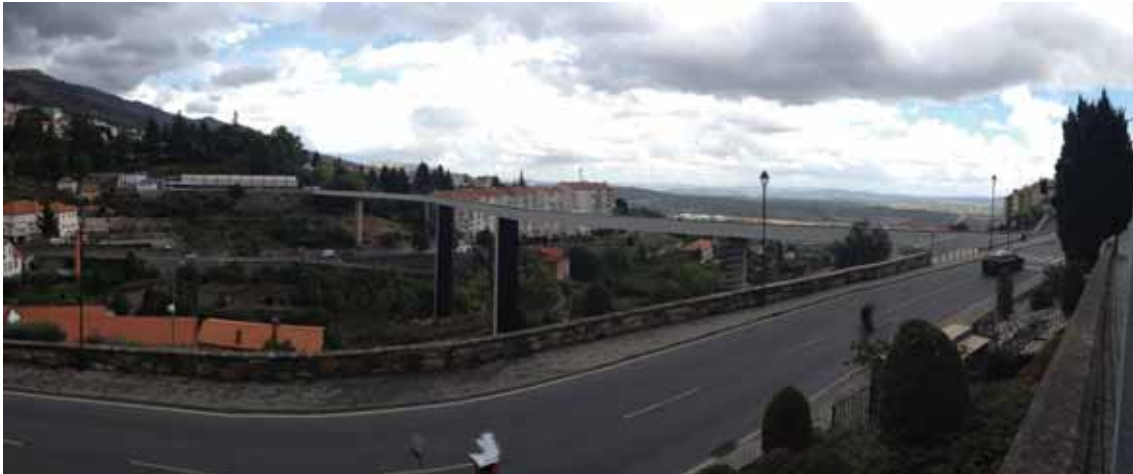
Figura 5.7 - Panorâmica da arquitetura da ponte, e das suas ligações às margens do Vale da Carpinteira
