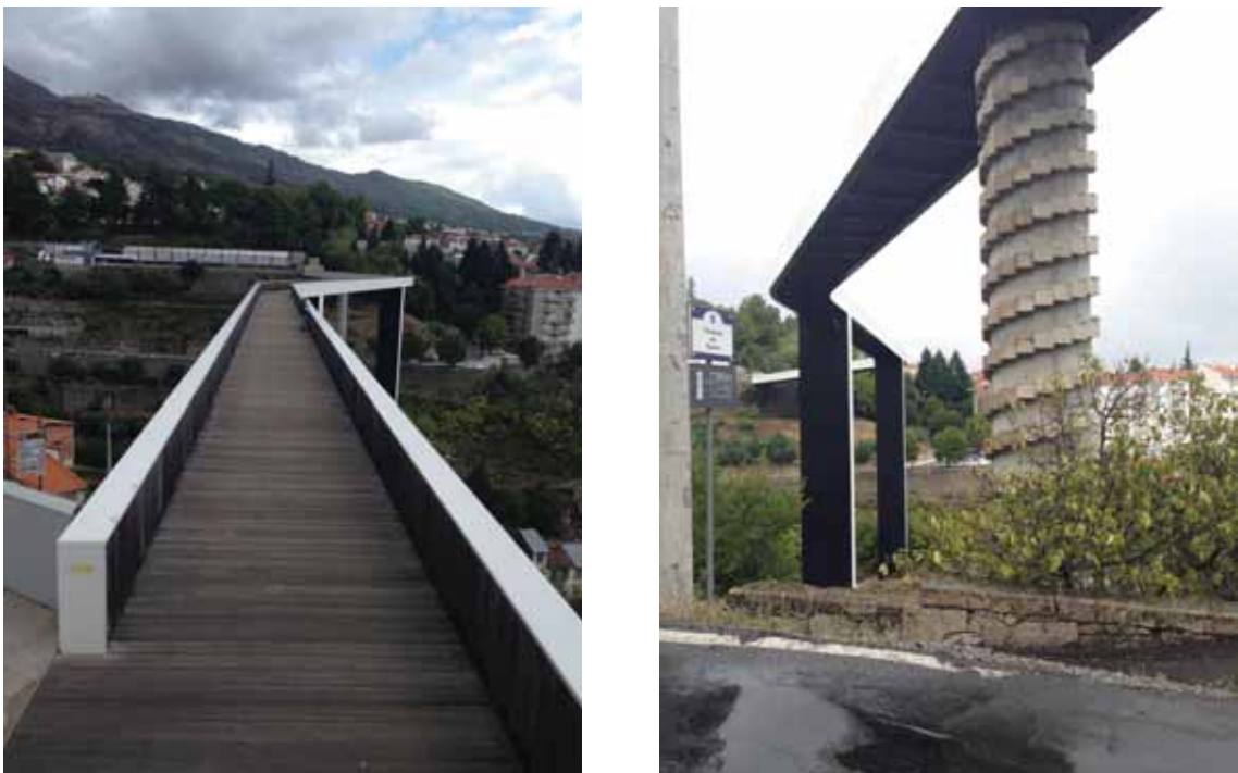
Figura 5.5 - Pormenores da Ponte da Carpinteira (esquerda: tabuleiro, direita: pilares)
