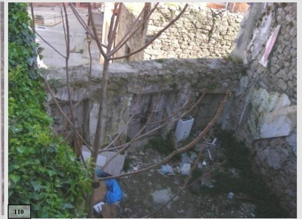
Imagens do interior do edifício 2
