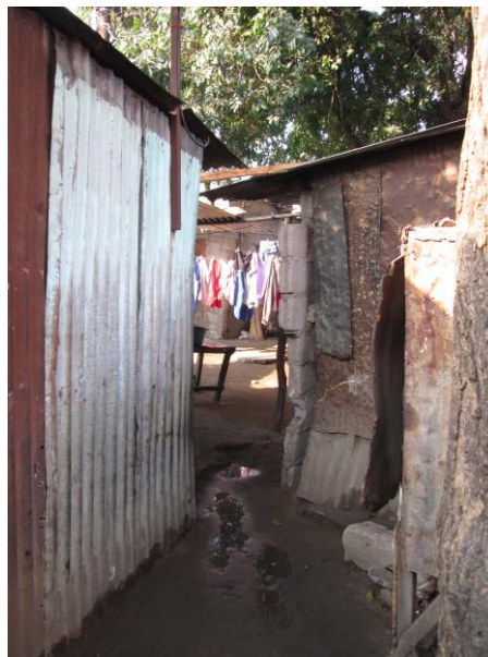
Figura 17. Casas construídas em locais inadequados no Bairro de Chamanculo C, 2013
