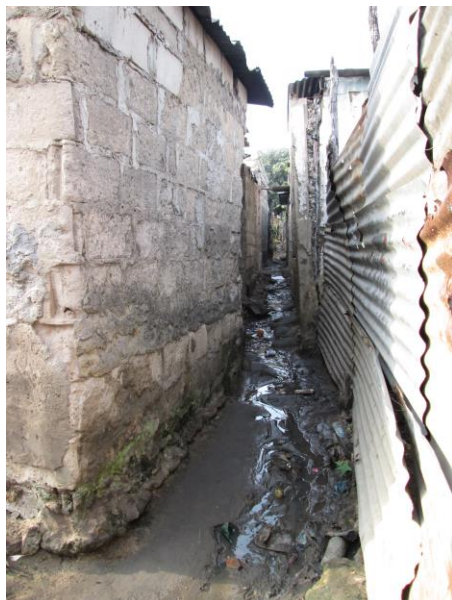
Figura 18. Ruas com espaçamento impróprio, construídas depois das cheias no Bairro de Chamanculo C, 2013
