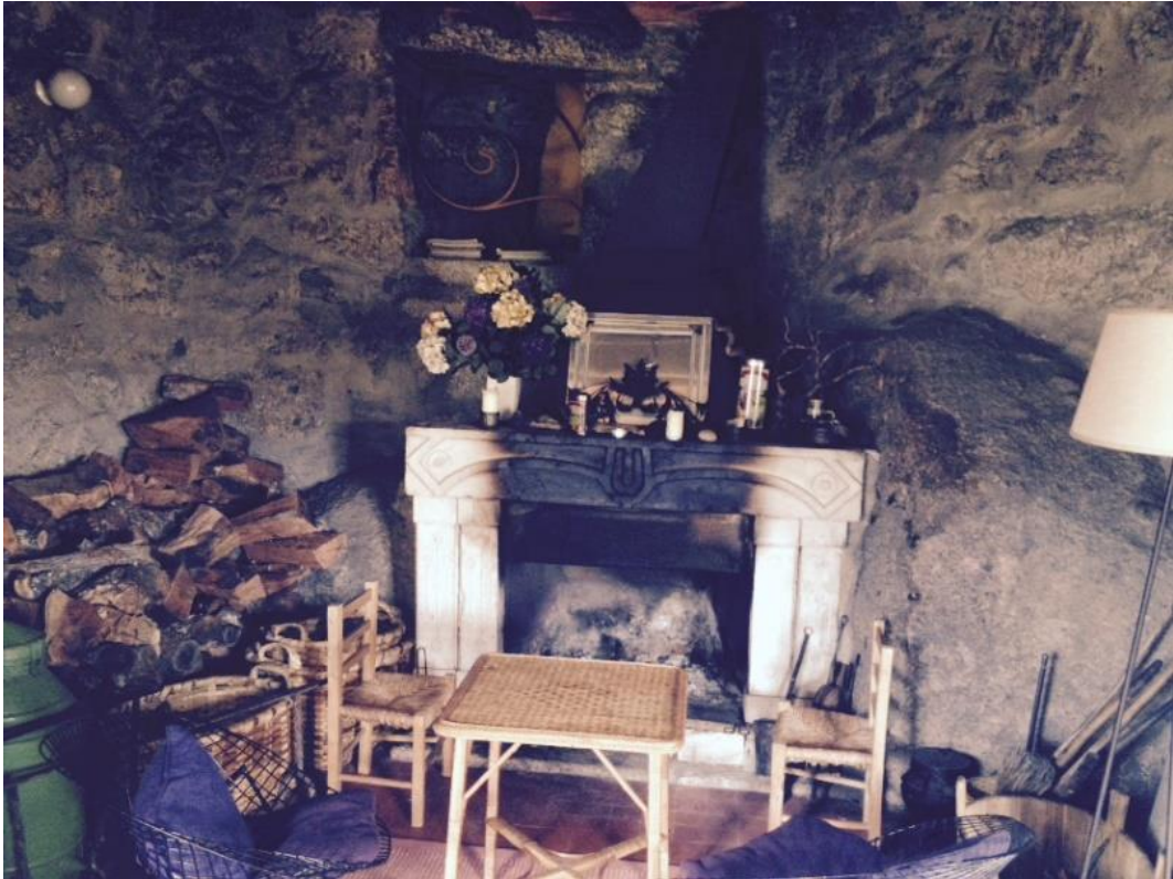
Fig. 20 - Casa da Serra - a lareira assente no afloramento rochoso.
