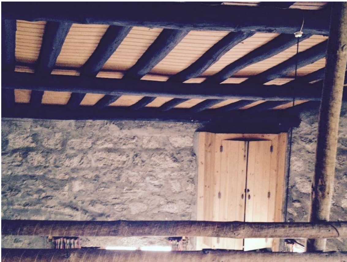
Fig. 29 - Casa da Serra - pormenor da estrutura da cobertura.
