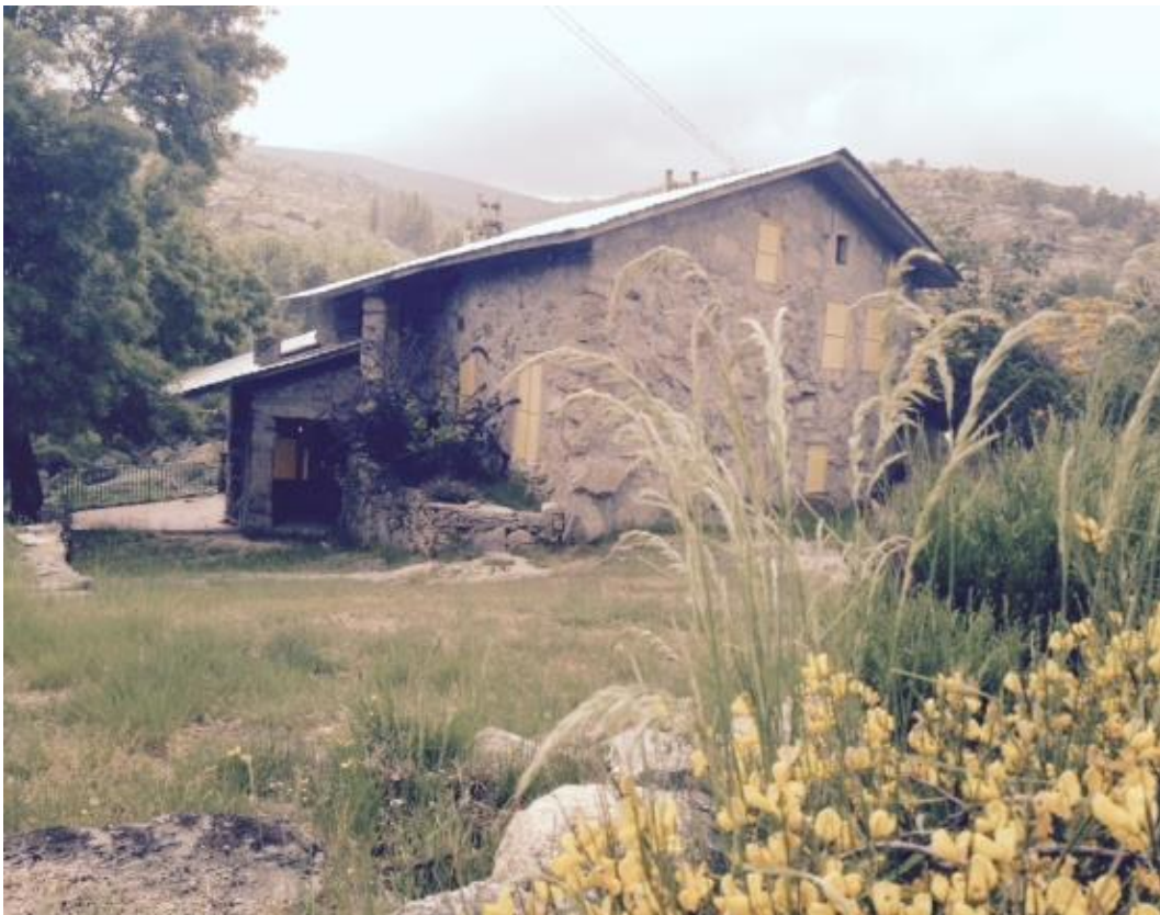
Fig. 19 - Casa da Serra - vista exterior com a paisagem da Serra de fundo.
