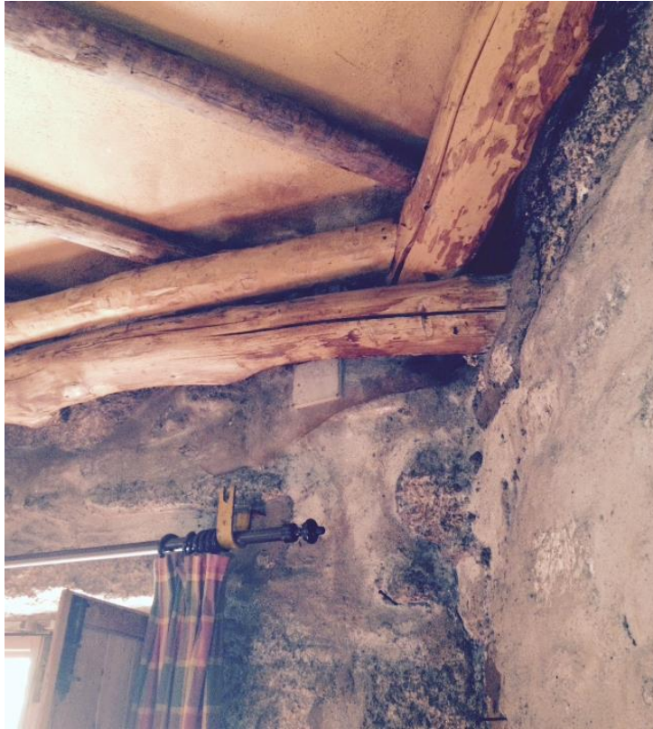
Fig. 28 - Casa da Serra - pormenor da estrutura de apoio da laje.
