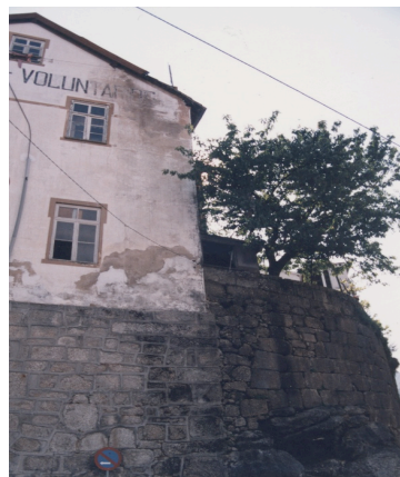
Figura 23 - Edifício antes da reconstrução
