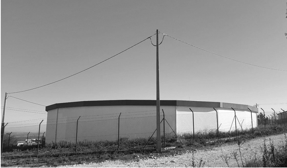
Figura 52 - Reservatório de água
