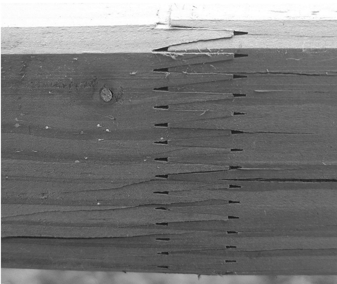
Figura 32 - Pormenor dos Passadiços do Paiva
