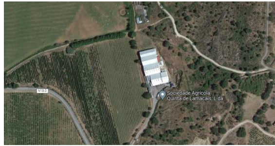
Figura 23 - Instalações Quinta dos Lamaçais (Google Maps, 2022).
