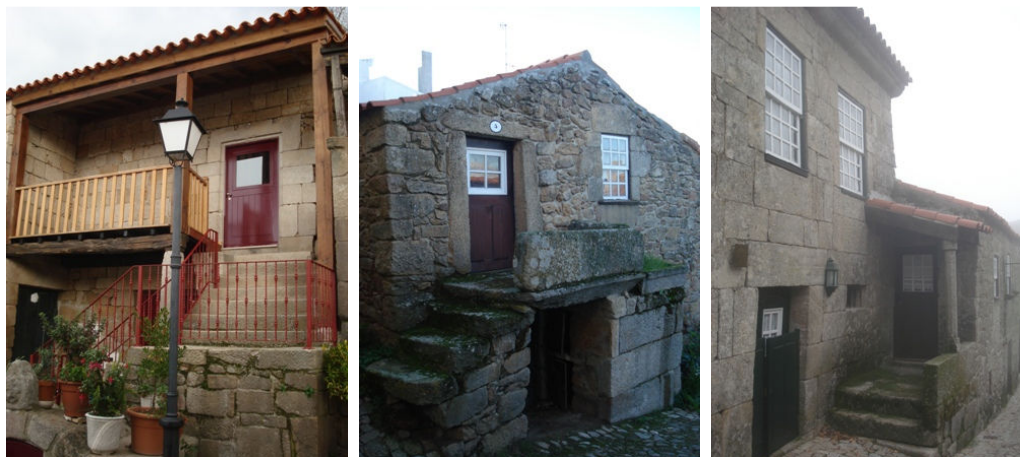
Foto 5 – Balcões das habitações tradicionais em Marialva, Castelo Mendo e Sortelha
