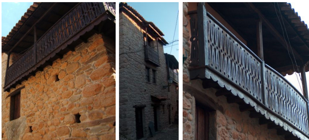
Foto 2 – Pormenores das habitações tradicionais no Paúl: em calhau rolado, 3 pisos e varanda alpendrada
