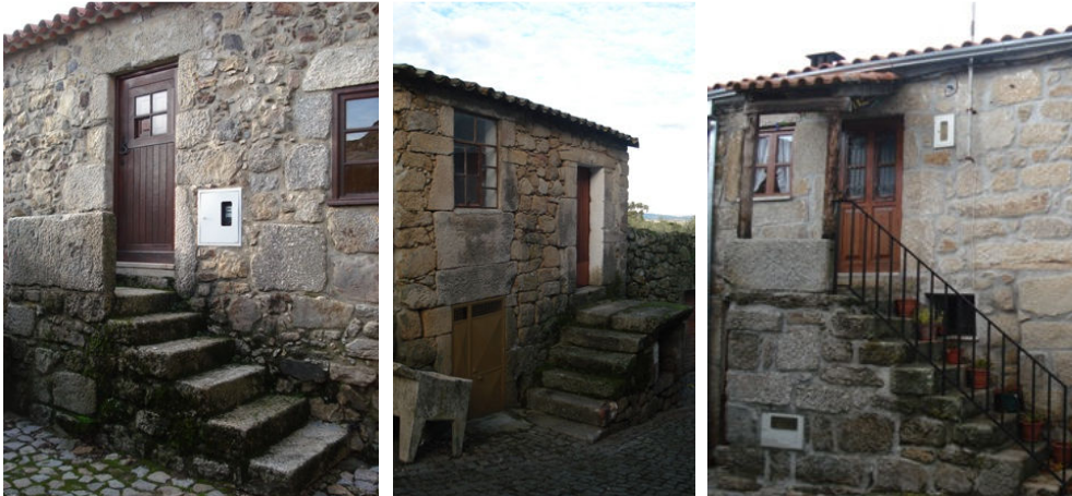
Foto 1 – Tipos de escadarias e alpendres de habitações tradicionais: Linhares, Celorico da Beira e Trancoso
