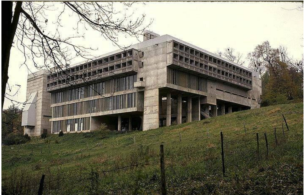
Figura 3 Panorâmica geral do edifício
