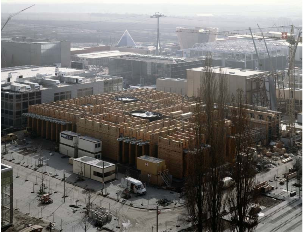
Figura 10 Vista Aérea do Pavilhão
