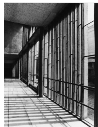
Figura 2 Panos de Vidro Ondulantes vistos do interior
