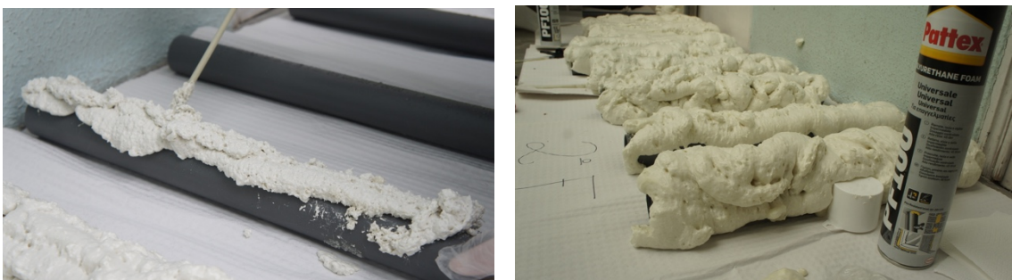
Figura 47: Aplicação da espuma de poliuretano.
