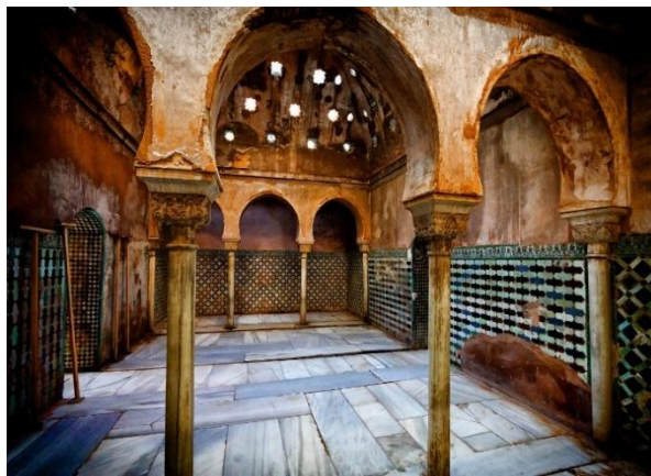
FIGURA 22- BANHOS COMARES (ANTES DA RESTAURAÇÃO), PALÁCIO NAZARI, ALHAMBRA, GRANADA, ESPANHA
