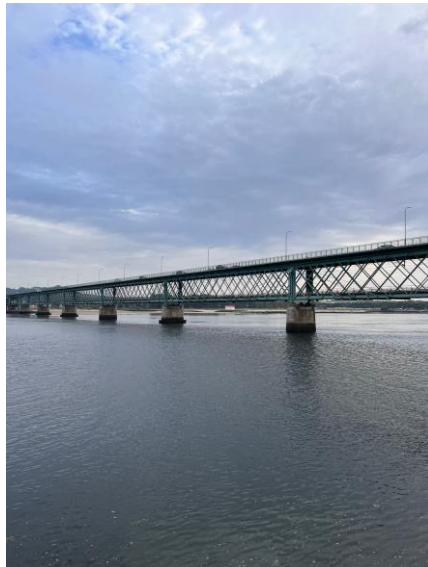
Figura 29 - Ponte Eiffel de Viana
