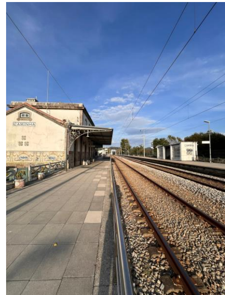
Figura 6 – Estação de Caminha
