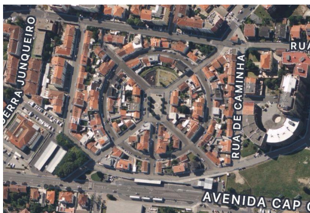
Figura 48 – Bairro do Jardim vista aérea
