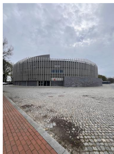
Figura 61 - Complexo Desportivo Praça de Viana
