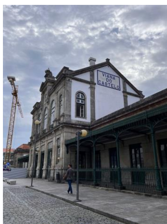
Figura 16 - Vista Lateral Estação de Viana do Castelo
