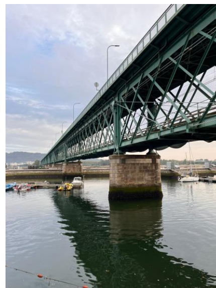
Figura 32 - Ponte Eiffel vista para Darque
