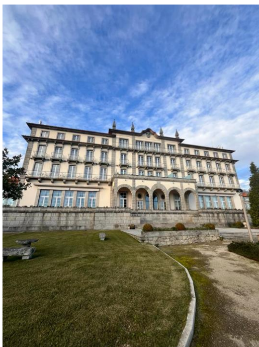
Figura 45 - Vista frontal do Hotel de Santa Luzia
