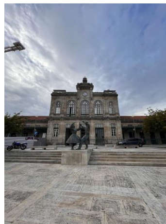
Figura 15 - Vista frontal Estação de Viana do Castelo
