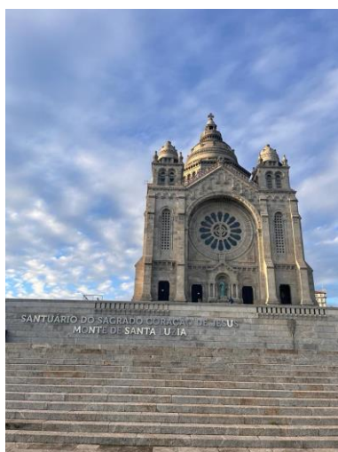
Figura 43 – Vista frontal da igreja de Santa Luzia
