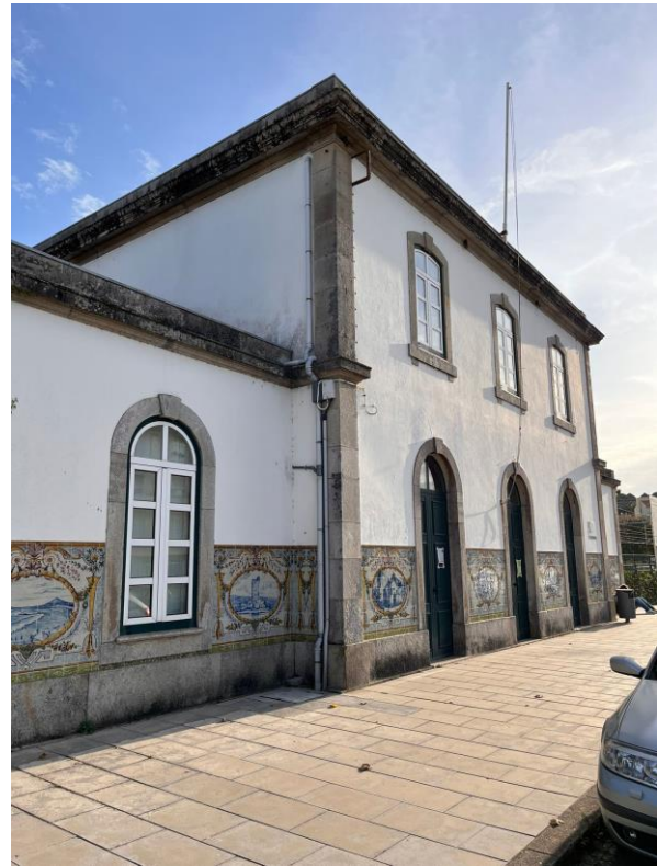
Figura 9 – Estação de Caminha
