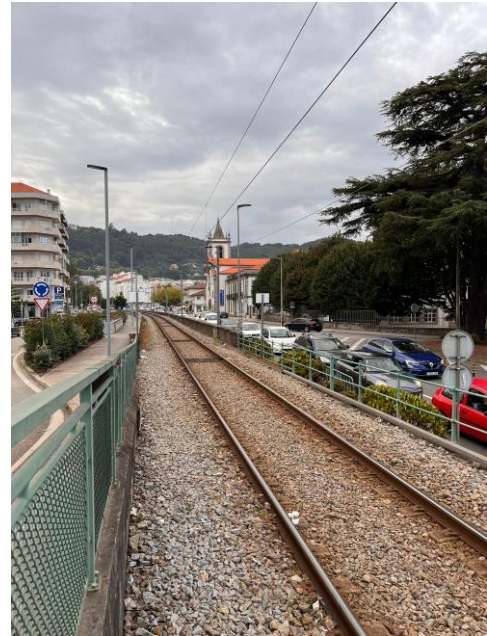
Figura 14 - Linha Férrea em Viana do Castelo
