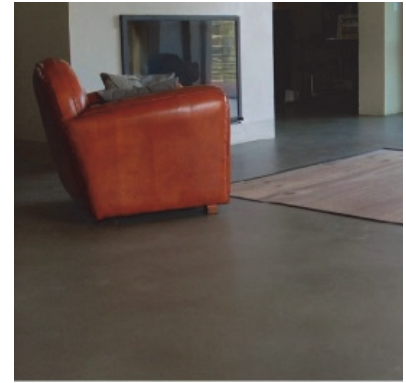
C - Piso em betão afagado 63
