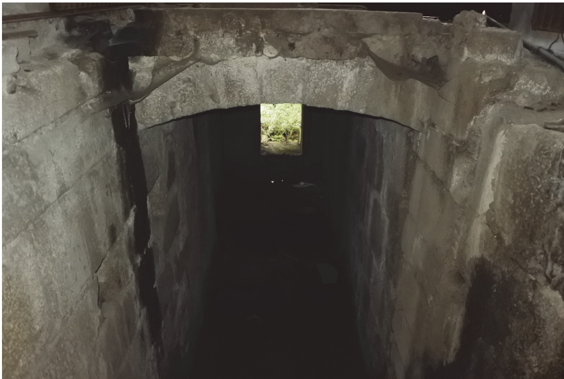
Figura 38 | Perspetiva interior do edificado - pormenor, piso -1 - existente 87
