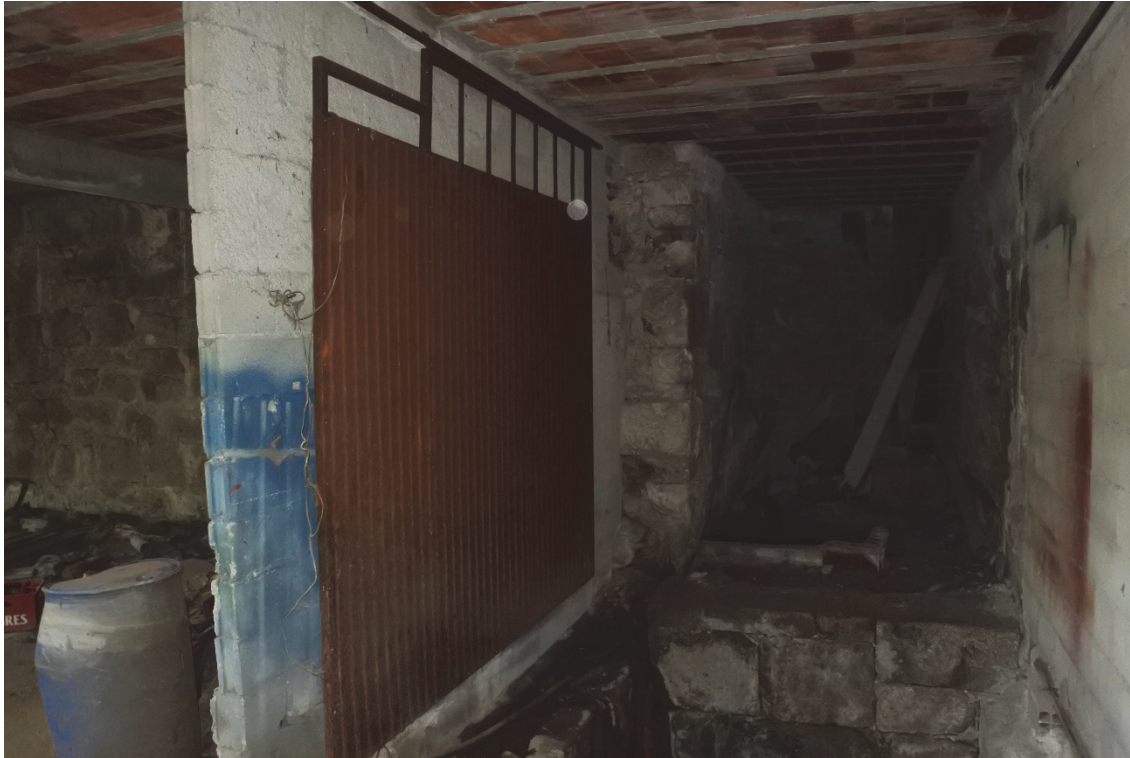
Figura 39 | Perspetiva interior do edificado - pormenor, piso -1 - Existente 88
