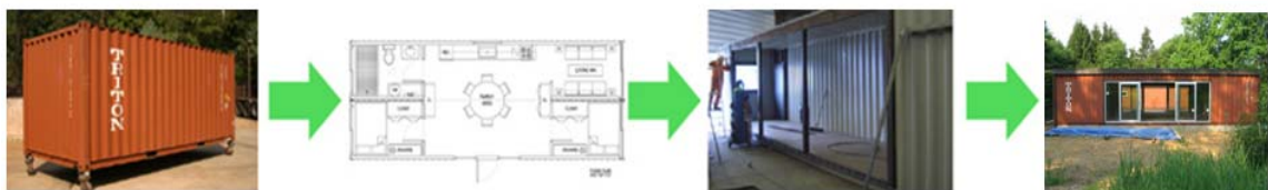
FIG. 59 Passos para a conversão de um contentor Triton na Old Lady House , de Adam Kalkin (New Jersey, USA) [RSCP, 2009] [i25]
