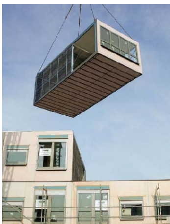
FIG. 136 Montagem de um módulo [ALHO, 2010] [134]
