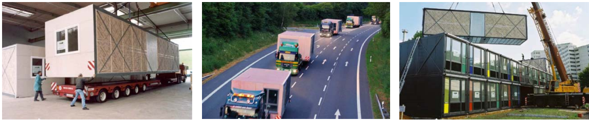
FIG. 101, 102 e 103 Transporte dos contentores pré-fabricados e posterior instalação [ALHO, 2010] [134]
