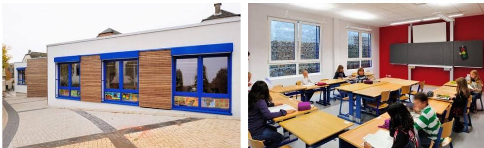
FIG. 131 e 132 Exemplo de uma escola construída com módulos estruturais [ALHO, 2010] [i34]
