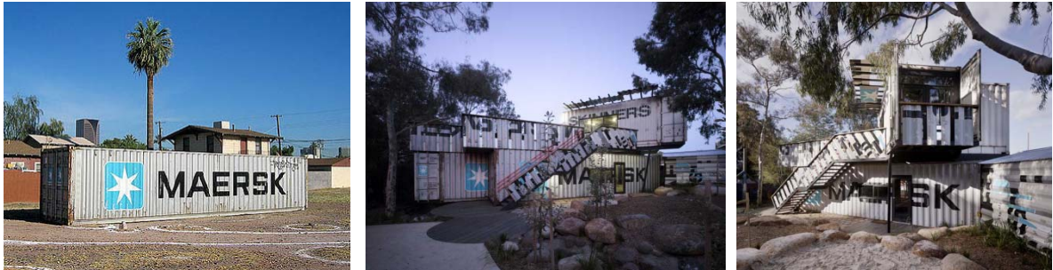
FIG. 148, 149 e 150 Contentor Maersk e a sua adaptação no projeto Children's Activity Centre , de Phooney Architects (Melbourne, Australia) [e-architect, 2008] [144]
