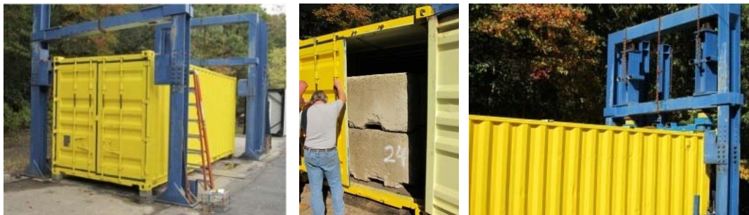
FIG. 143, 144 e 145 Ensaio de carga ISO e medição das eventuais deformações [Staxxon, 2010] [143]
