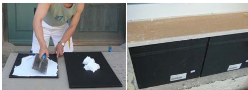
FIG. 18 Aplicação de painéis de isolamento por vácuo [va-Q-tech, 2010] [16]
