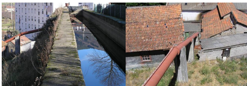
Figura 26 - a) Aqueduto com 360m b) Conduta adutora
