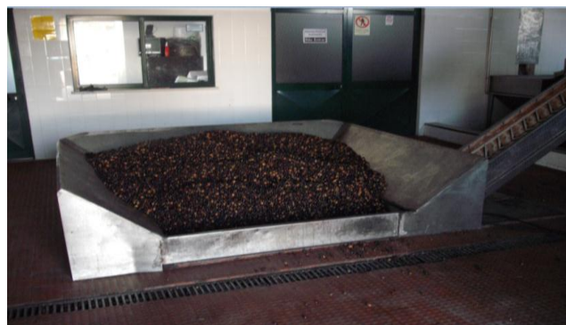
Figura 22 - Tegão de recepção onde é descarregada a azeitona à entrada do lagar
