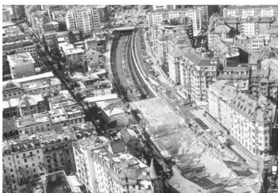
Figura 25 Vista aérea em construção
