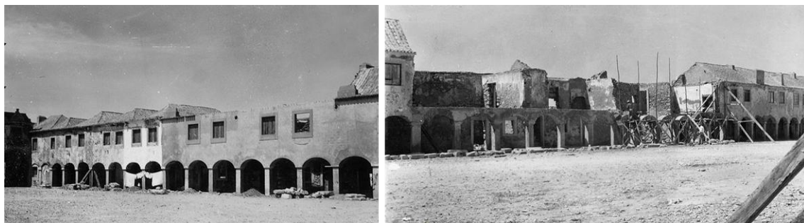
Figura 79 Obras iniciadas pela DGEMN nos anos 60, principalmente escoramento de paredes, pilares e coberturas.
