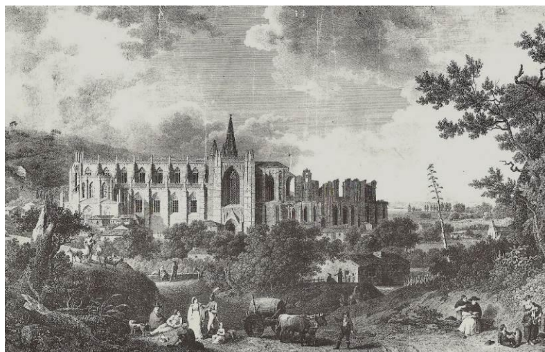
Figura 4 Ilustração do Mosteiro da Batalha antes das obras de restauro.
