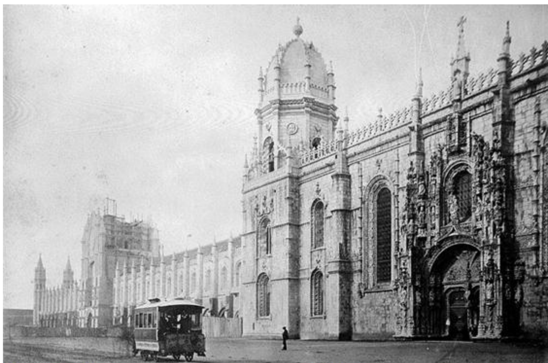
Figura 1 Mosteiro dos Jerónimos, em Lisboa, aquando das obras de reconstrução da fachada principal.
