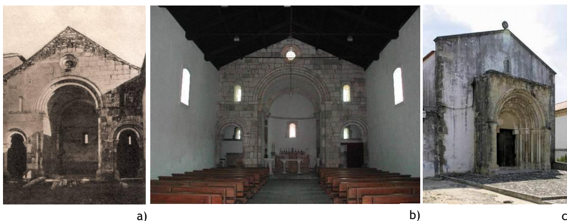
Figura 9 a) Ruínas da Igreja de S. Pedro de Leiria; b) Interior da Igreja de S. Pedro de Leiria depois das obras de restauro; c) Fachada da Igreja de S. Pedro e Leiria atualmente.
