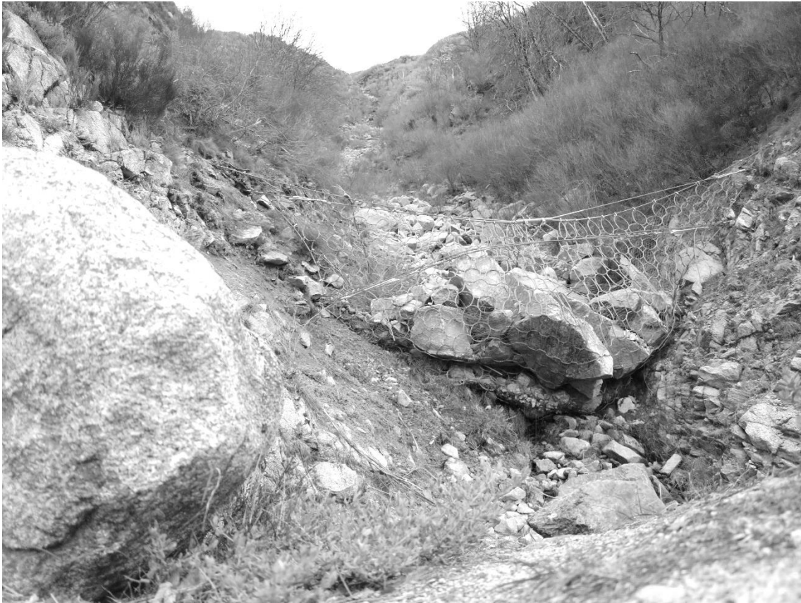
Figura 42 - Vedação metálica EN338 no vale do Zêzere.
