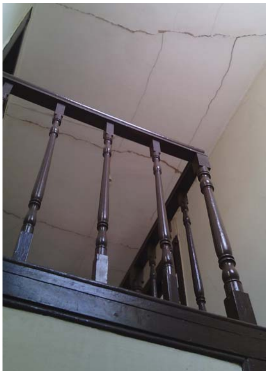
Fig. 4.1 - Corrimão e balaústres em madeira
