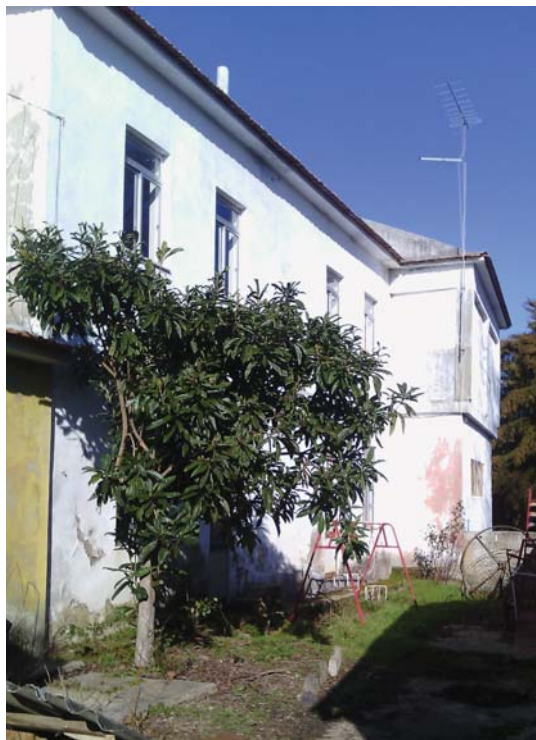
Fig. 4.2 - Fachada Sudeste do edifício da Junta de Freguesia de Peredo
