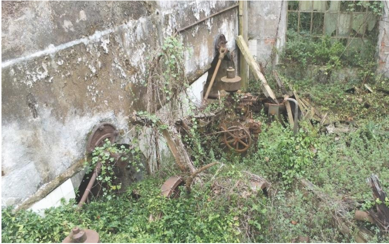
Figura 106 CGE – Átrio, turbinas e parte dos geradores, 2021 (fotografia do autor)
