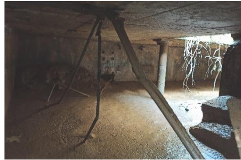
Figura 94 CGE - Cave Técnica, abertura no piso da Central, 2021 (fotografia do autor)
