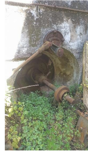
Figura 107 CGE – Átrio, turbina fabricada por J.M.Voith (fotografia do autor)
