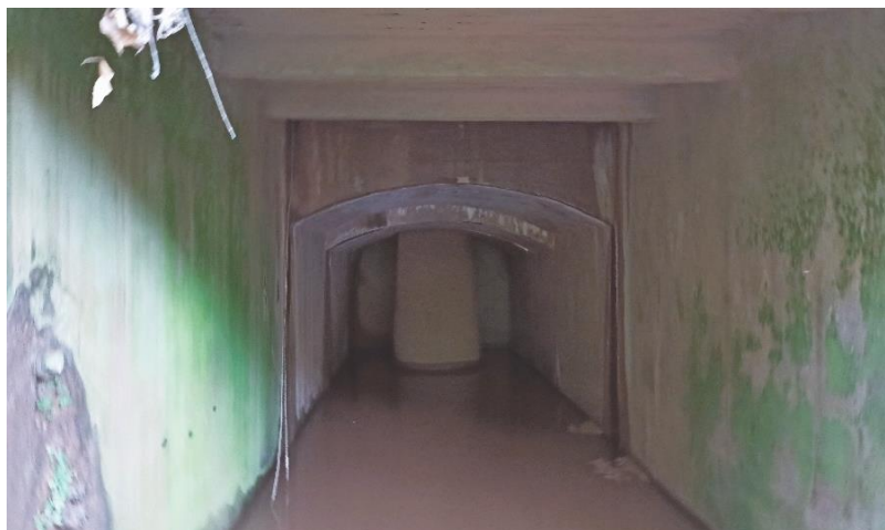
Figura 105 CGE - Túnel, vista interior, 2021 (fotografia do autor)
