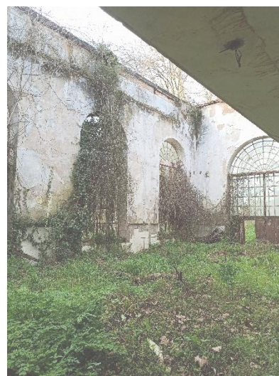
Figura 119 CGE – Átrio, vista do painel elétrico (fotografias do autor)
