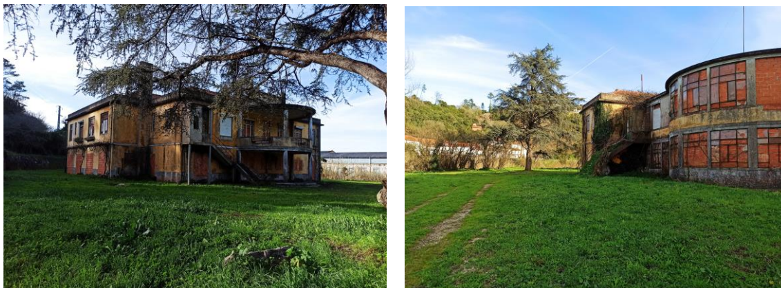
Figura 31 AAG - estado atual do edifício (fotografias do autor)
