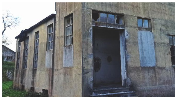
Figura 130 PTE – alterações na fachada (fotografia do autor)
