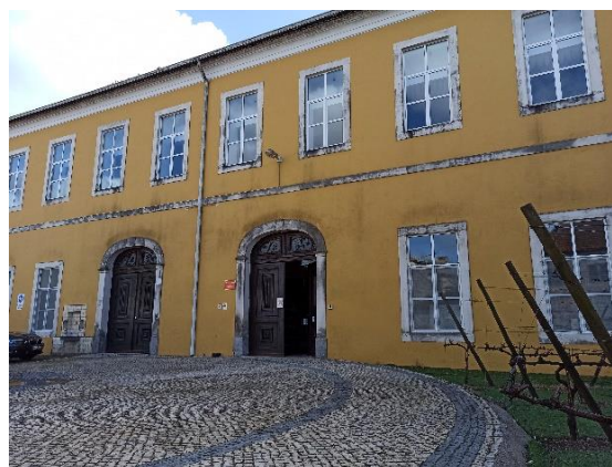
Figura 39 CF - Edifício principal do complexo fabril, bem conservado, 2022 (fotografia do autor)
