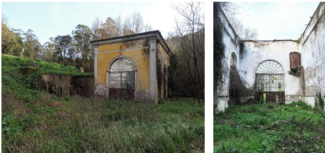
Figura 24 CGE - estado atual da Central (fotografias do autor)
