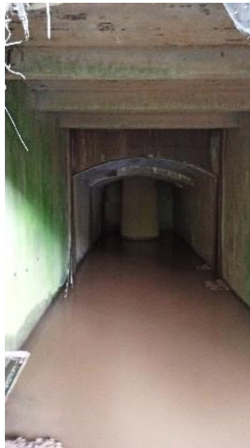
Figura 96 CGE - Túnel de descarga da Turbinas, 2021 (fotografia do autor)
