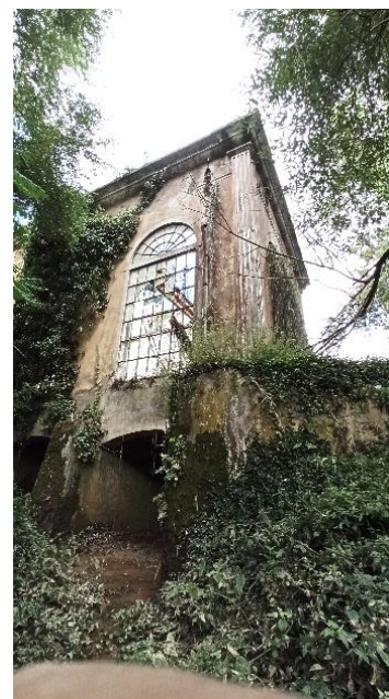
Figura 97 CGE - Central e Tunes de descarga de água, 2021 (fotografia do autor)
