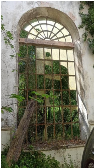
Figura 95 CGE – Janela Átrio, 2021 (fotografia do autor)
