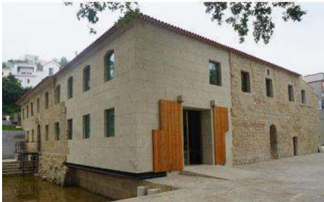
Figura 31 - Vista sobre o cunhal reconstruído
