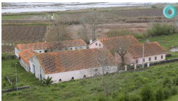
Figura 39 - Antigo complexo abandonado das termas do Bicanho
