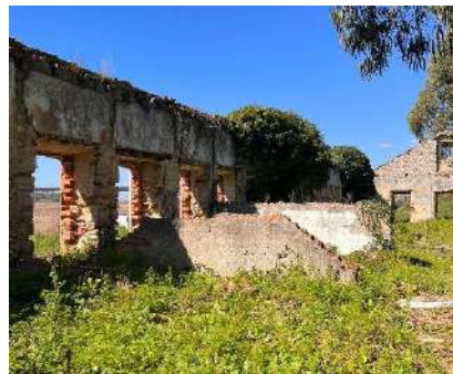
Figura 52 - Vista interior do edifício
