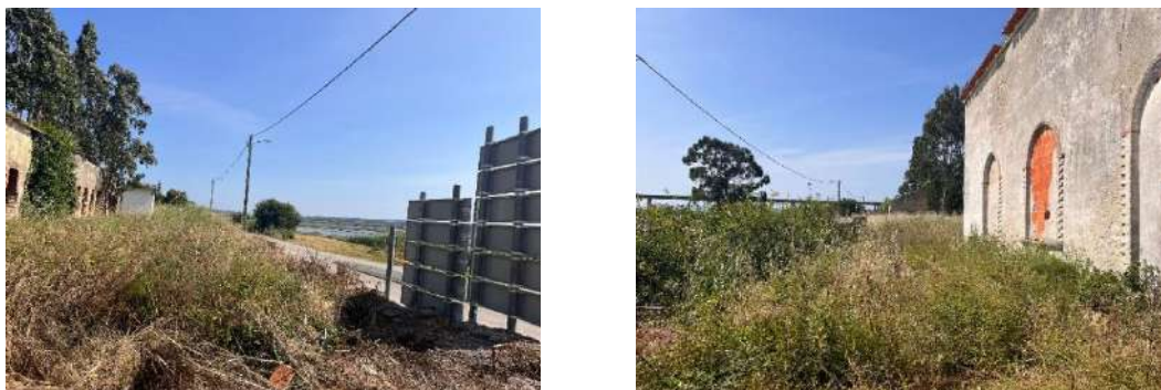
Figura 51 - Fotografias do local de intervenção
