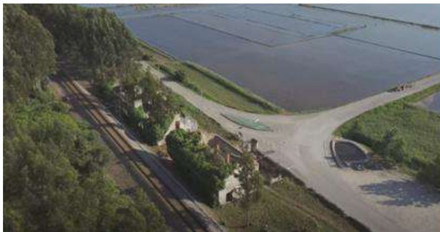
Figura 46 - Vista aérea de alguns edifícios em ruína do complexo
