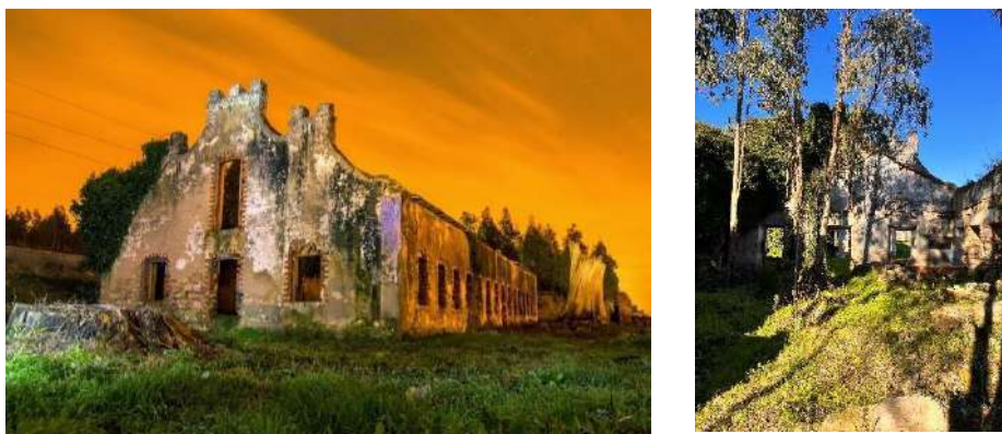
Figura 59 - Vista exterior e interior do edifício, respetivamente
