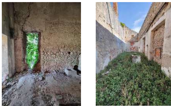
Figura 57 - Fotografias do interior do edifício 2
