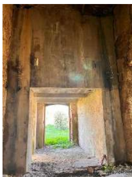
Figura 58 - Fotografia da parede aumentada em betão
