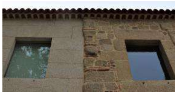
Figura 30 - Fachada norte do edifício. Pormenor da caixilharia dos vãos e das pingadeiras
