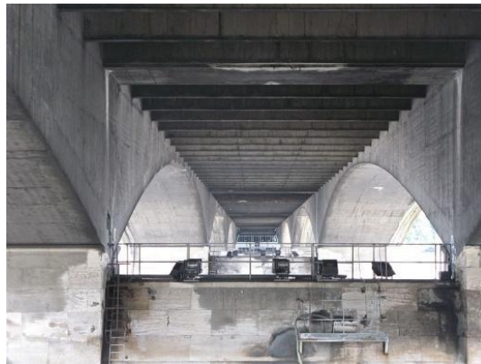
Figura 2 - Vista inferior da ponte [4]
