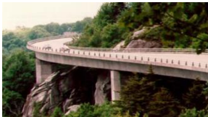
Figura 13 a) - Vista geral da ponte
