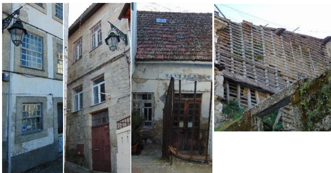
Fig. 137 | Estado das Fachadas, (da esquerda para a direita, fachada norte, fachada este, fachada sul e fachada oeste).
