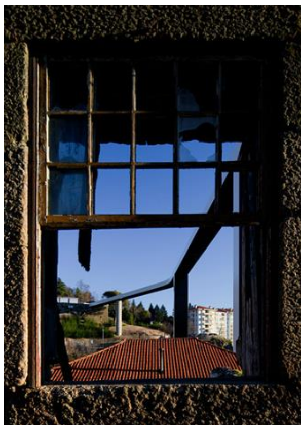
Fig. 97 | Ponte Pedonal, Carrilho da Graça, Covilhã. [34]
