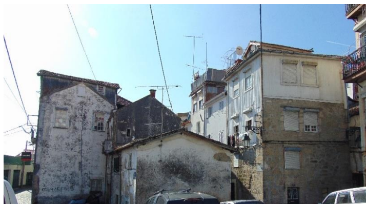
Fig. 114 | Estado de alguns edifícios, Covilhã.
