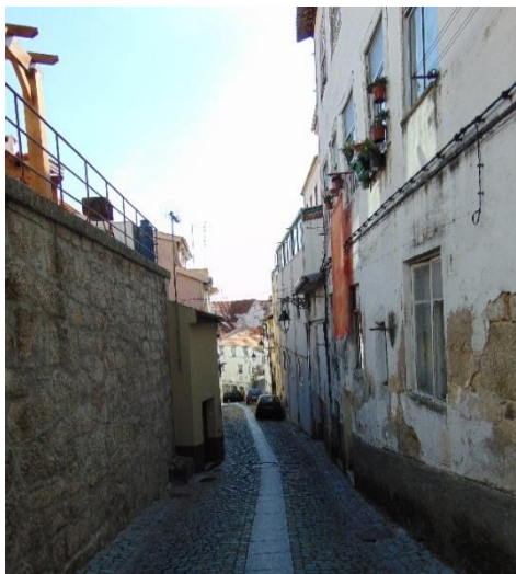
Fig. 128 | Portas de entrada com contacto imediato para a rua.
