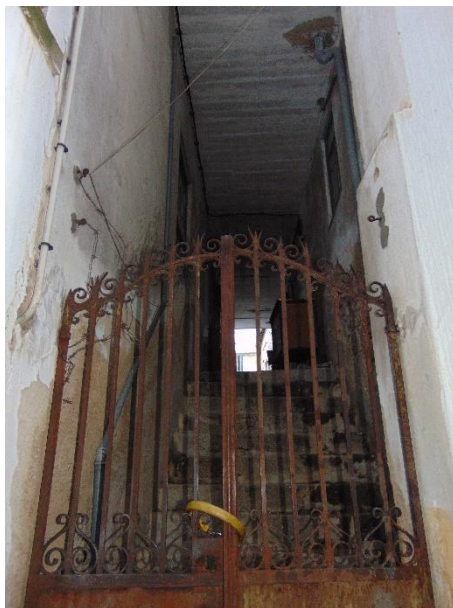
Fig. 149 | Portão localizado na Rua do Batoréu.
