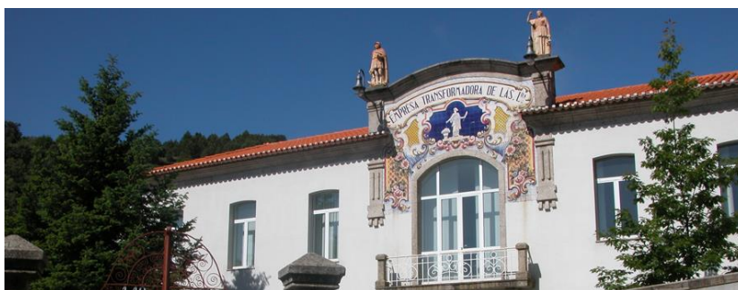
Fig. 68 | Empresa transformadora de Lãs atualmente Faculdade de Engenharia, Covilhã. [30]
