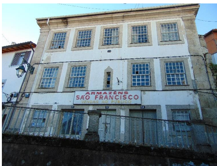
Fig. 129 | Edifício antigos armazéns São Francisco.
