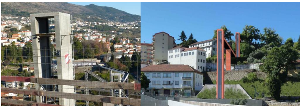
Fig. 49 e 50 | Elevador do jardim (em construção), Covilhã. [83]
