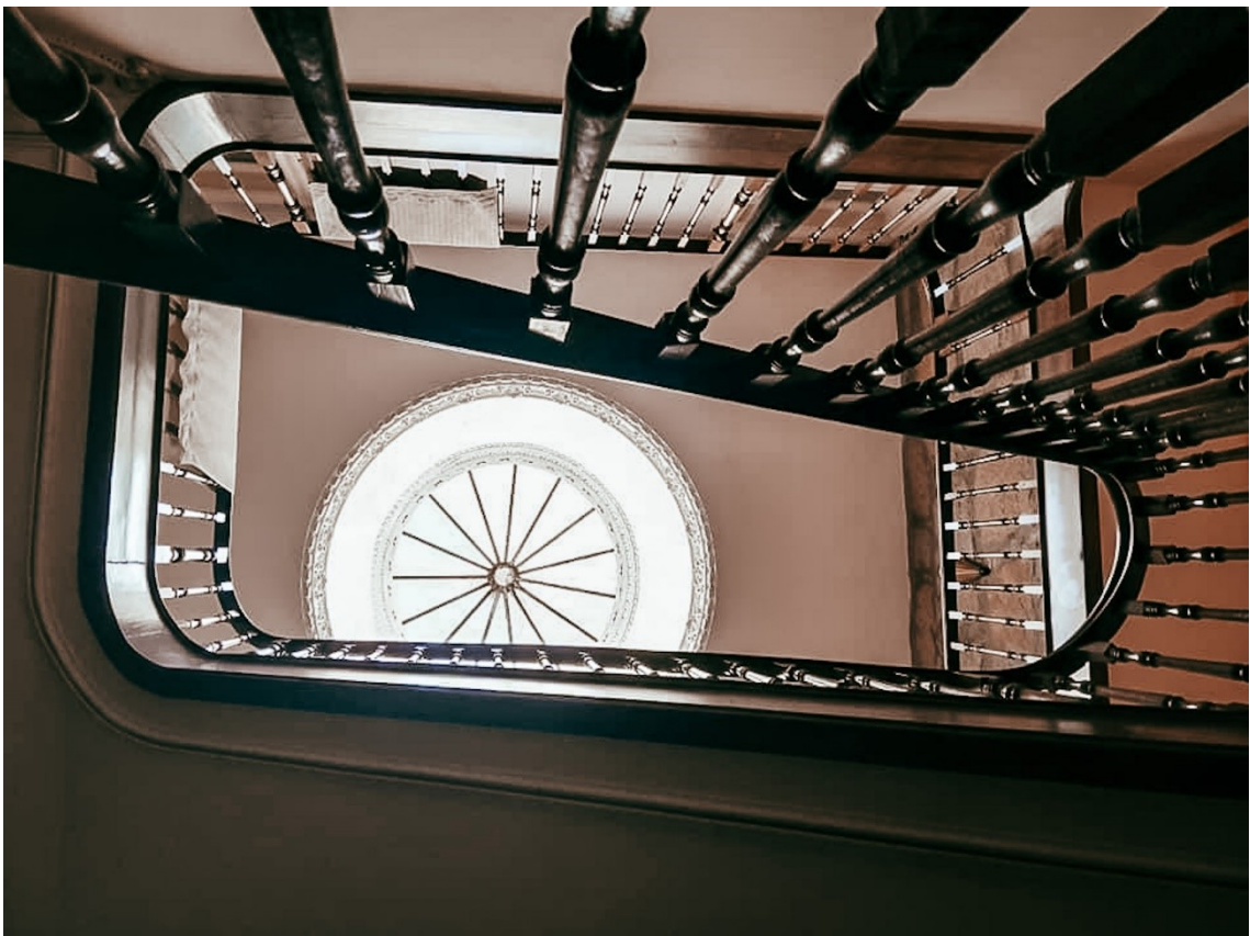
Figura 75 - Edifício nº305B, rua do Bonfim. FONTE: Fotografia da autora
