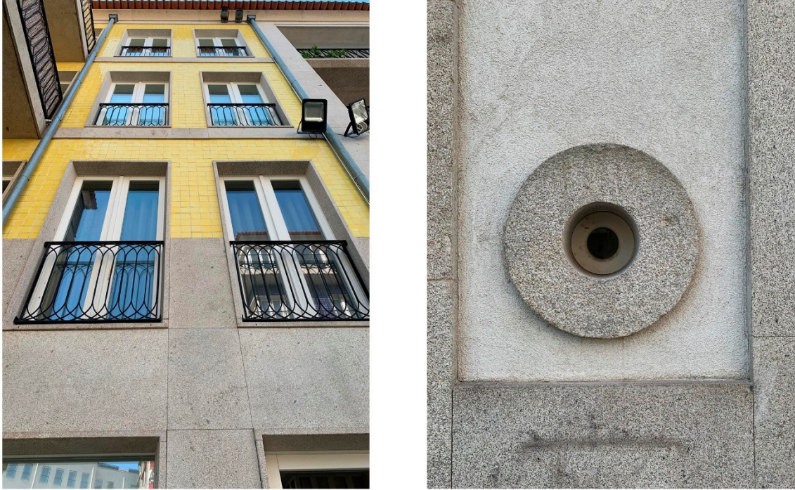
Figura 36 - Edifício no interior do Quarteirão das Cardosas. FONTE: Fotografias da Autora.
