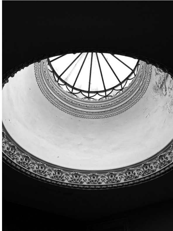
Figura 71 - Claraboia do edifício 305A. FONTE: Fotografia da autora.
