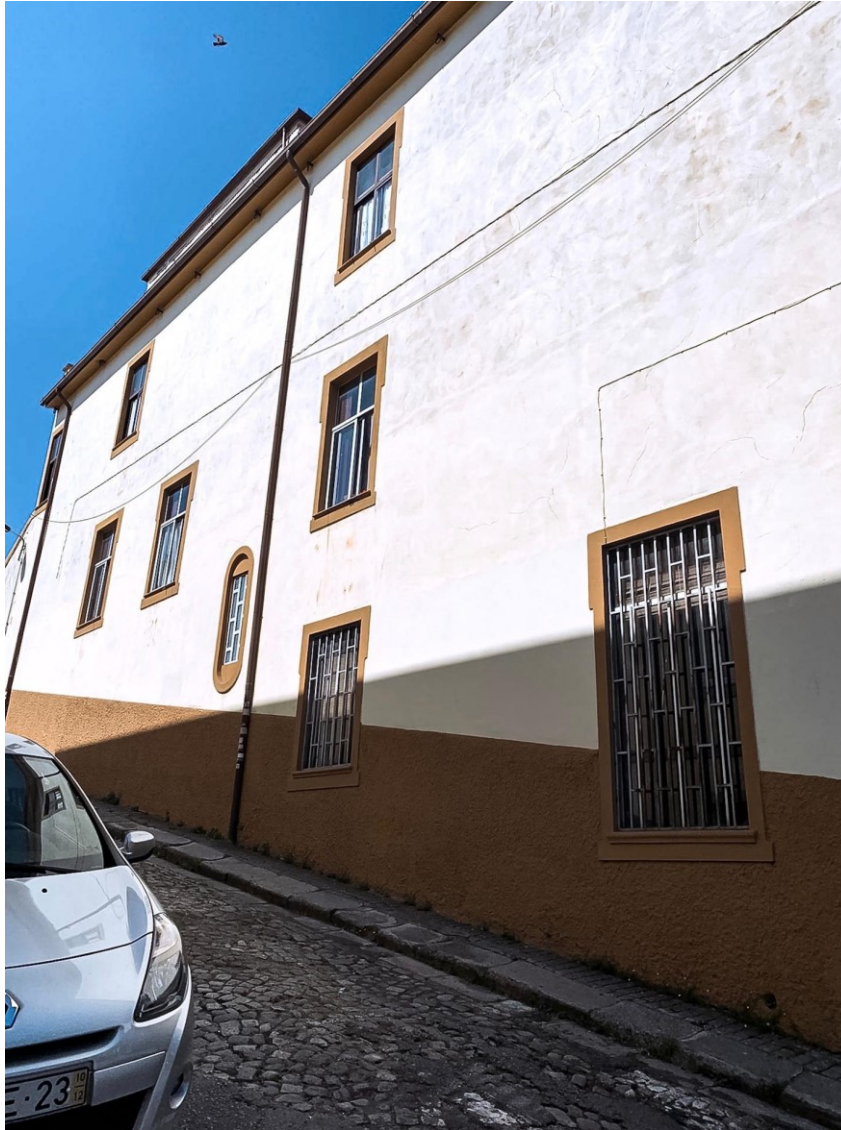
Figura 56 - Fachada lateral do edifício 303/305. FONTE: Fotografia da autora.
