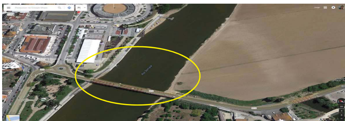
Figura 4.8 - Vista aérea da ponte sobre o rio Sorraia. Objeto de estudo 13 .
