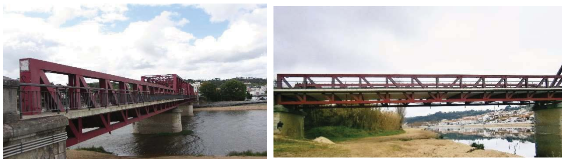
Figura 4.4 - Vista do tramo metálico mais recente construído após o acidente de 1979.
