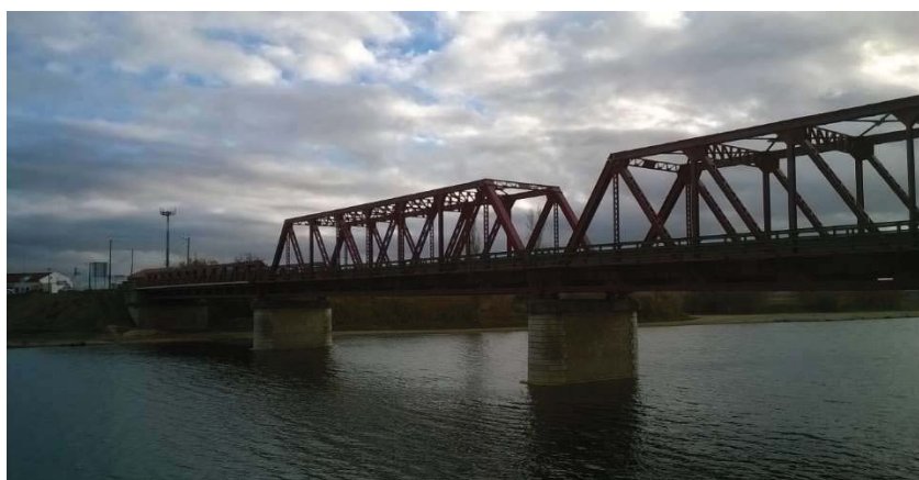
Figura 2.15 - Ponte de Coruche. Viga treliçada do tipo Pratt.
