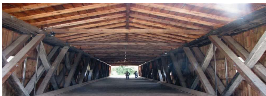
Figura 2.11 - Interior da ponte Jay em nova York (Treliza Howe) 4 .
