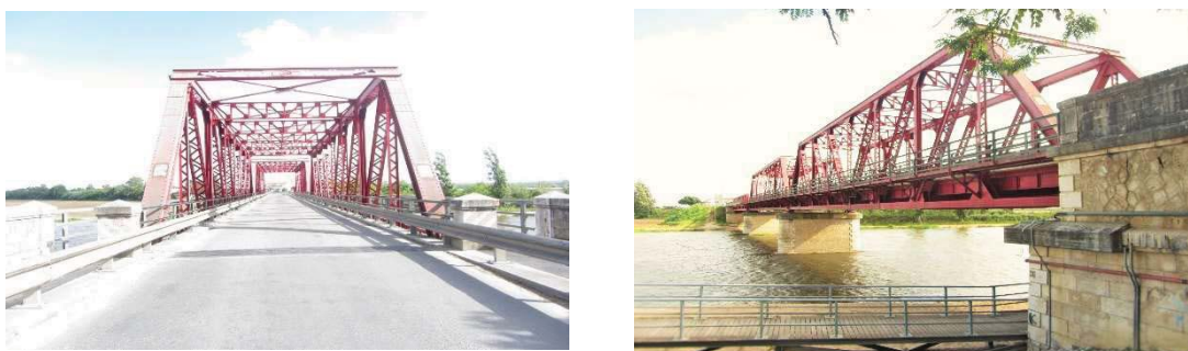
Figura 4.1 - Fotografia da ponte General Teófilo Trindade (objeto de estudo), lado Norte ( E2).
