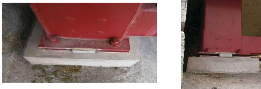
Figura 4.13 - Aparelhos de apoio do primeiro tramo da ponte.
