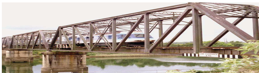
Figura 2.14 - Ponte sobre o rio Hastis, Austrália. Viga treliçada do tipo Pratt 5 .
