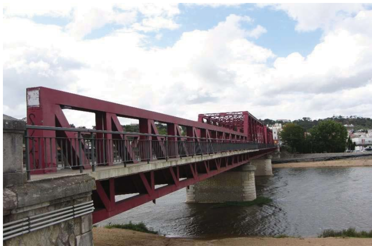
Figura 2.19 - Primeiro tramo (sentido Sul-Norte) da Ponte de Coruche.
