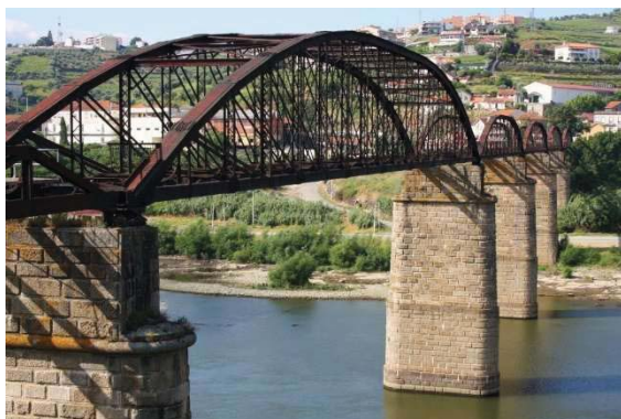
Figura 2.5- Ponte da Régua, Peso da Régua.
