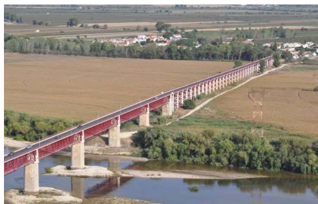
Figura 2.17 - Ponte de D. Luís em Santarém 6 .
