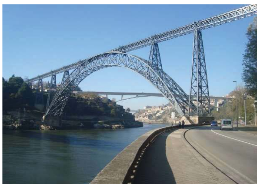
Figura 2.4- Ponte Maria Pia, Porto.
