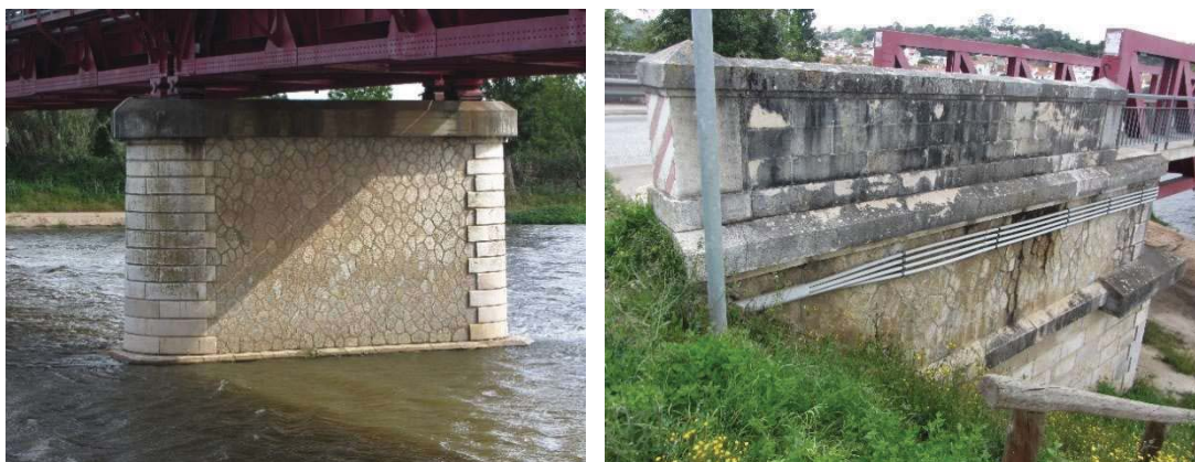
Figura 4.10 - a) Fotografia dos pilares em alvenaria (P2) b) Fotografia do encontro sul da ponte (E1).
