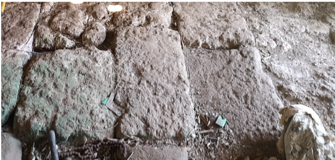
Figura 66 - Pavimento em pedra de cantaria do interior de uma habitação, Buildingazores, 2019
