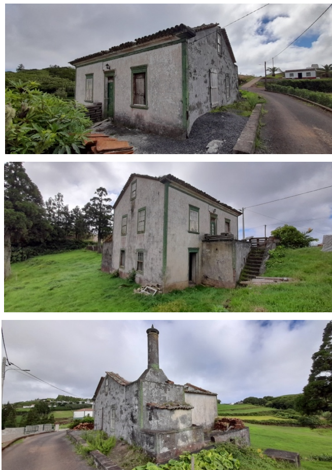
Figura 56 - Casa de duas águas, adaptada ao declive do terreno, tendo balcão e loja, Santo Espírito (Buildingazores, 2022)
