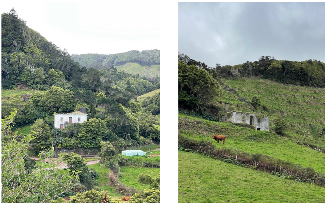
Figura 49 - Casas balcão em estado de degradação avançado e ruína, Santa Bárbara, 2023
