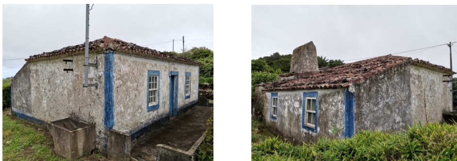
Figura 80 – Casa-tipo com ampliação no alçado tardoz, Santa Bárbara (Buildingazores, 2020)
