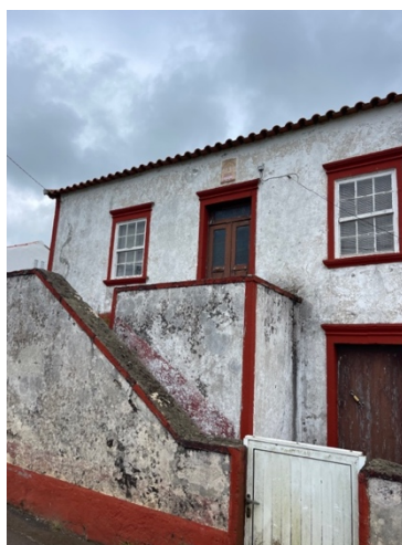
Figura 73 -Muro da casa típicas, socos, cunhais e molduras pintados, Almagreira 2023
