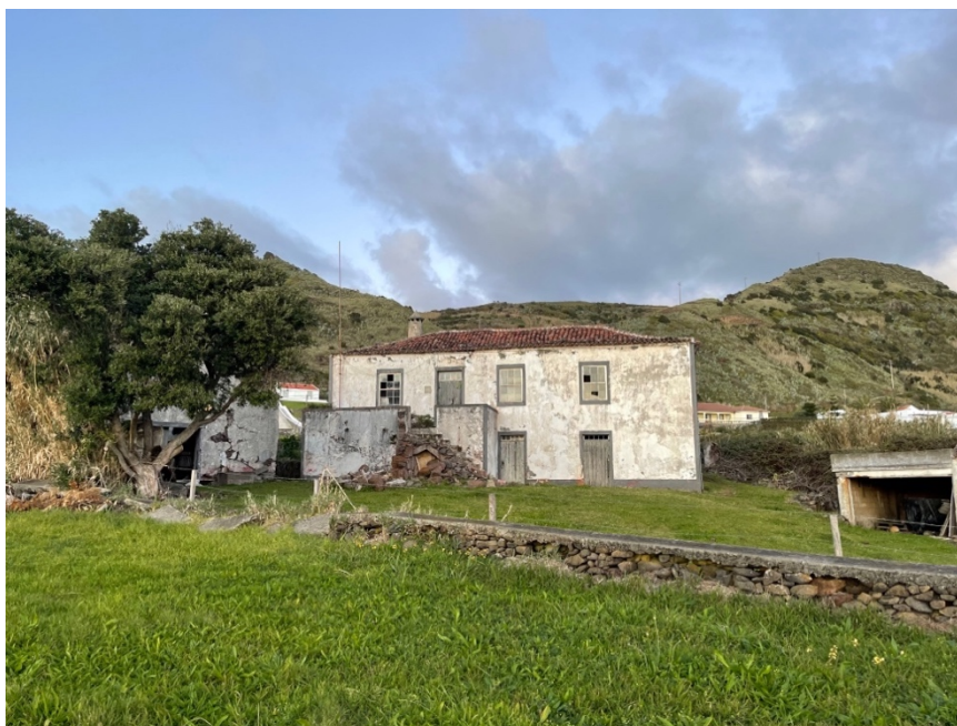
Figura 63 - Casa abastada na Praia Formosa, Almagreira, 2023
