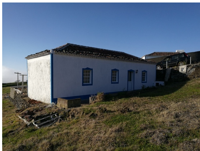
Figura 97 - Casa alongada, fachada principal antes da reabilitação, Santa Bárbara, Norte (Buildingazores, 2016)
