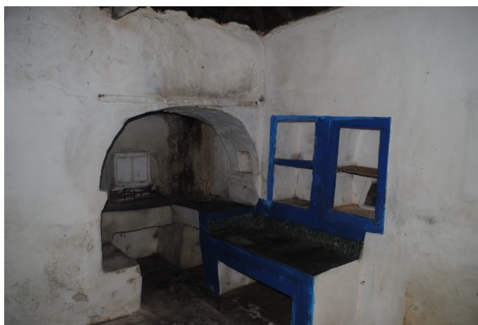
Figura 44 - Interior da casa, área da cozinha, o arco e o forno (Buildingazores, 2020)
