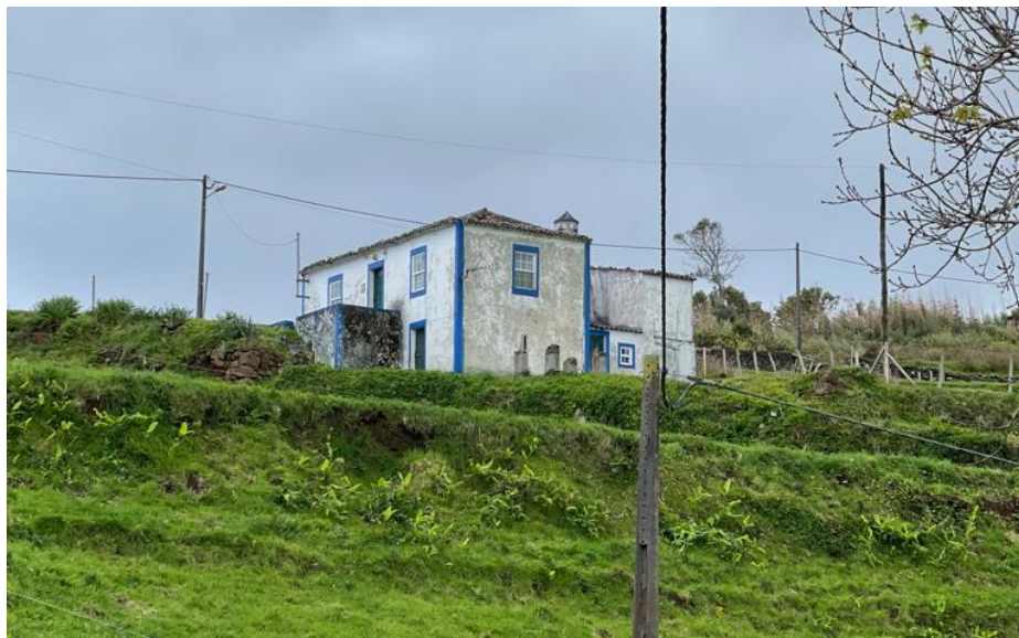
Figura 87 - Casa rural mariense com sucessivas alterações, Santa Bárbara, 2023
