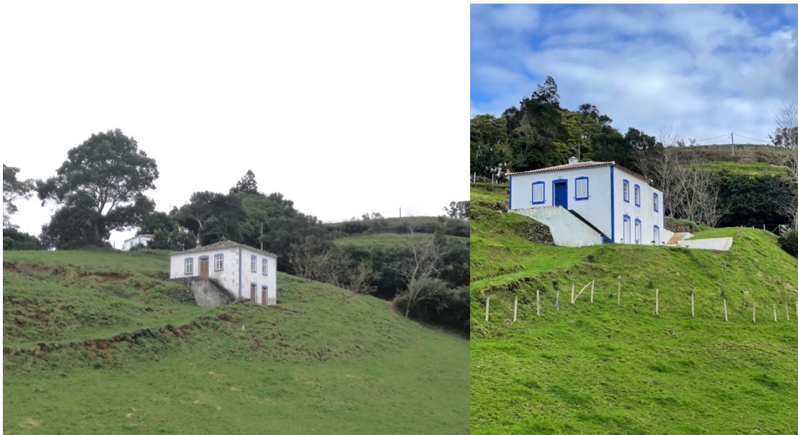
Figura 91 - Casa balcão antes da reabilitação, Santa Bárbara (Builingazores, 2019)
