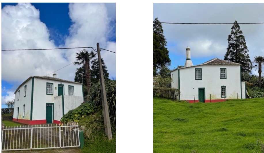
Figura 78 - Exemplo de uma ampliação na parte tardoz da casa, e a fachada principal, Santo Espírito, 2022
