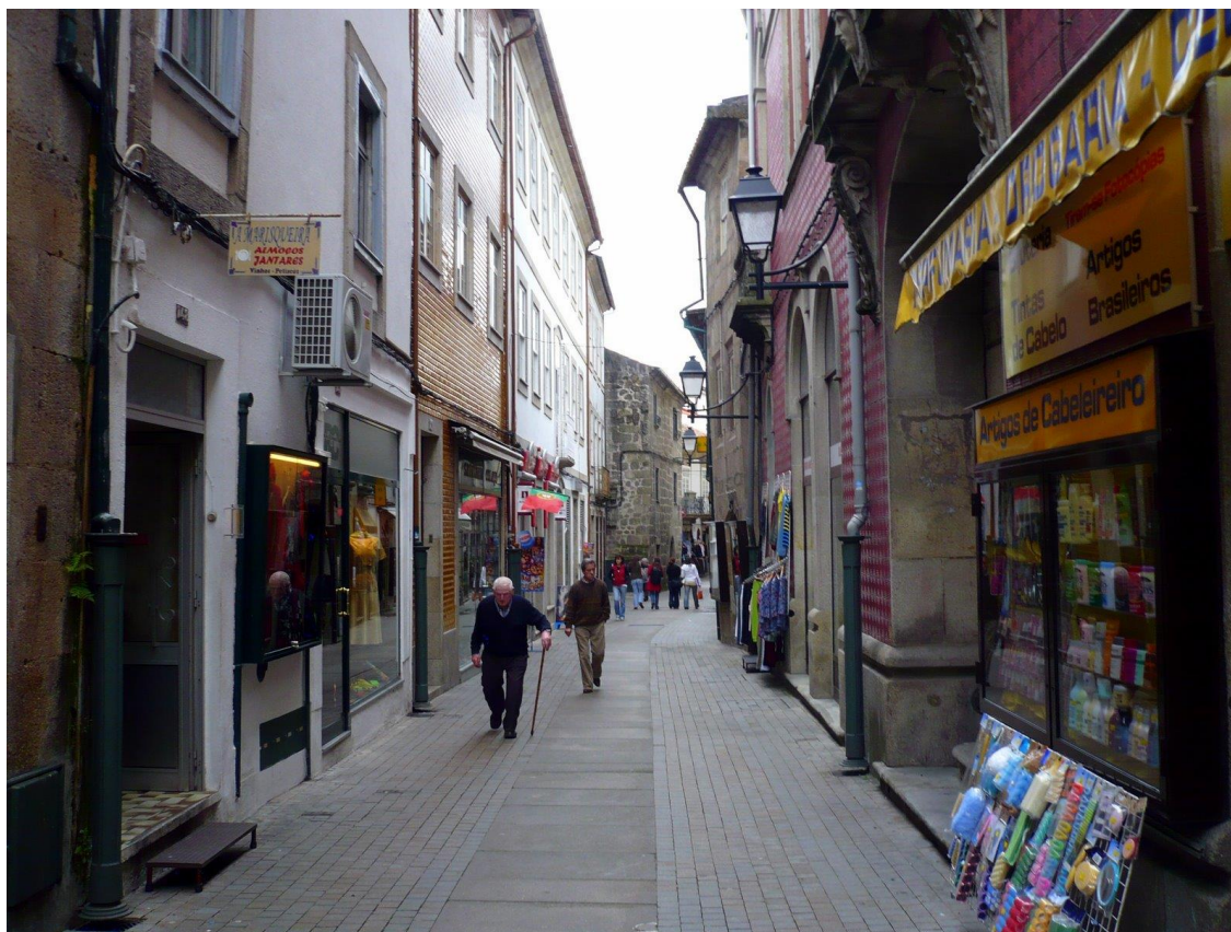
Imagem 24 - Rua Direita - Exemplos de irregularidade construtiva ao nível das alturas, larguras e materiais dos edifícios
