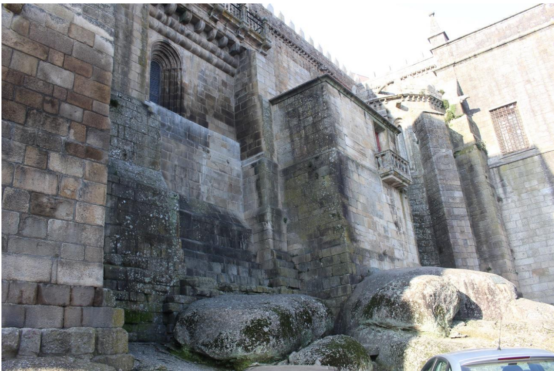
Imagem 83 - Vista da entrada do logradouro do edifício a partir da Rua da Boa Morte - fachada tardez da Sé Catedral de Viseu
