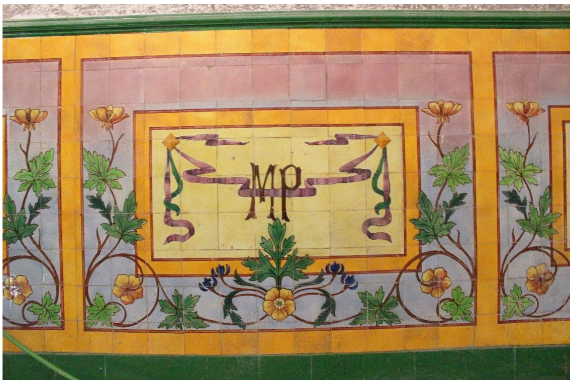
Imagem 68 - Revestimento cerâmico com motivos florais na parede do hall de entrada principal
