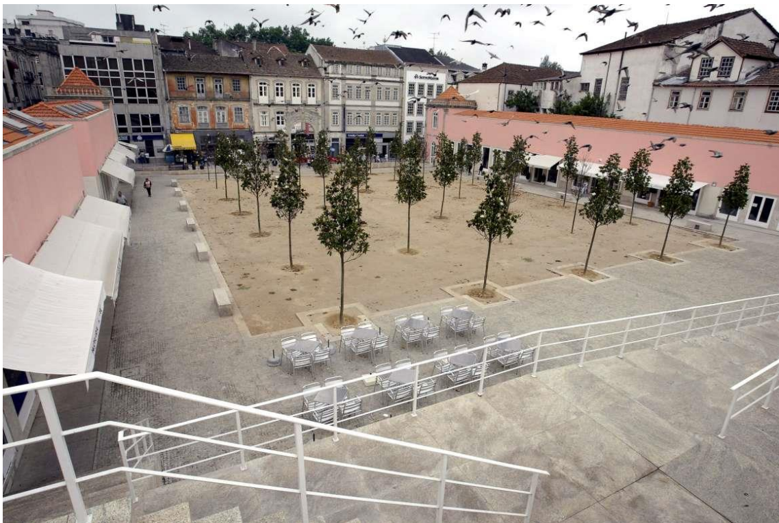
Imagem 32 - Mercado 2 de Maio na atualidade - Reabilitação da autoria do Arquiteto Álvaro Siza Vieira - 2002
