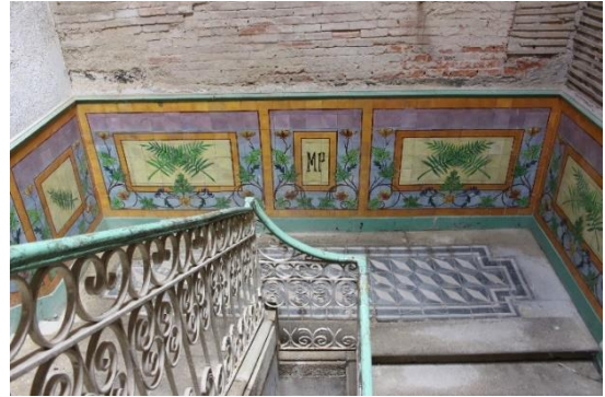
Imagem 72 - Patamar da escadaria de pedra
