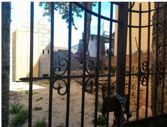
Imagem 122 - Fotografia das escavações que estão a decorrer no logradouro do edifício - Fotografia da autora, tirada a 1 de Julho de 2016
