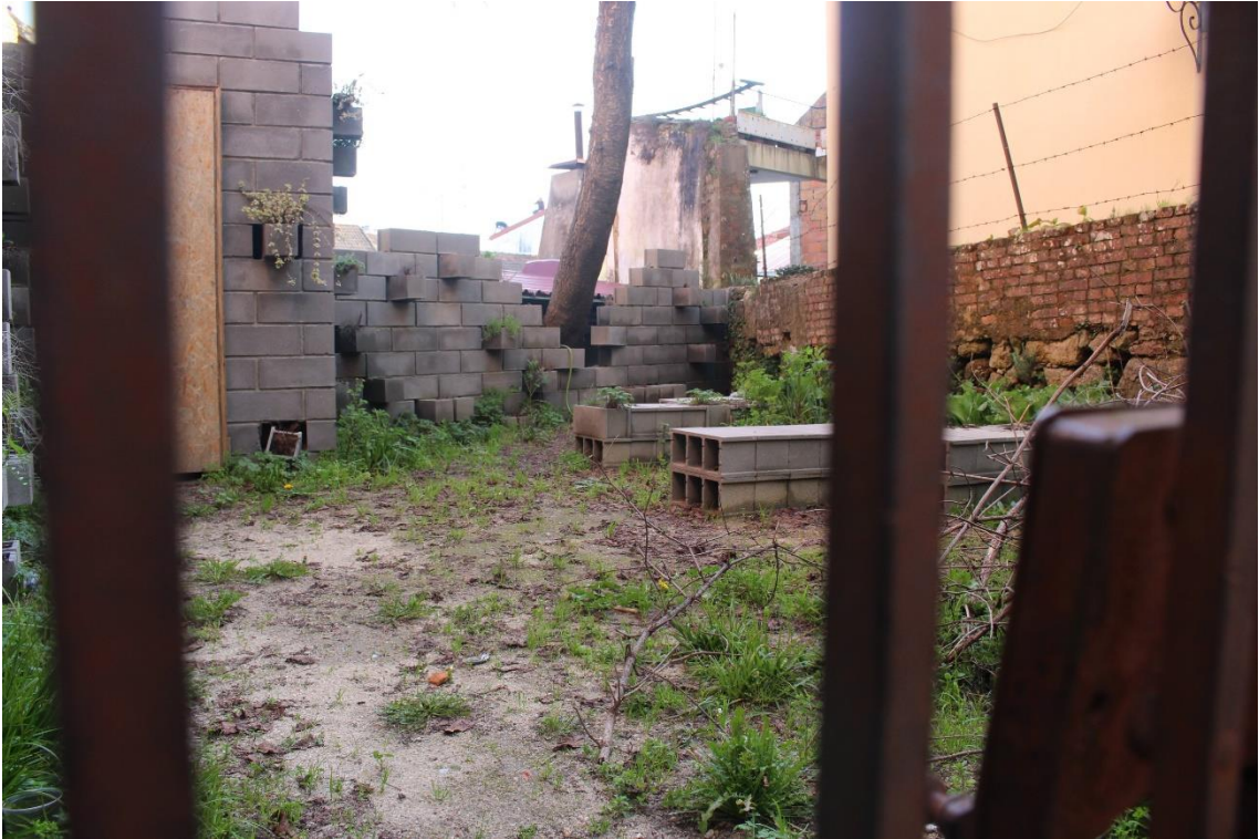
Imagem 82 - Logradouro do edifício
