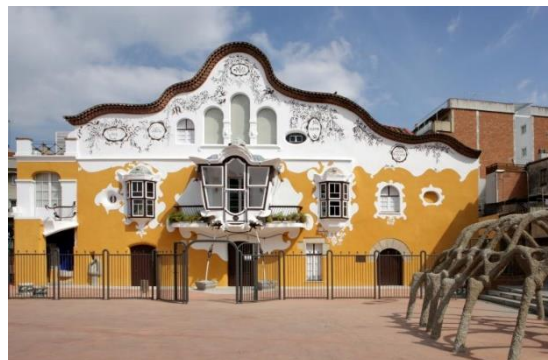
Imagem 125 - Fachada principal da Fazenda Can Negro após intervenção
