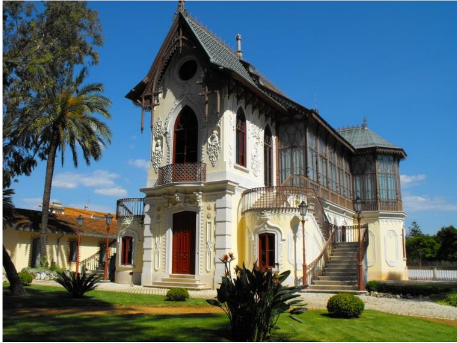
Imagem 128 - Fachada principal do estúdio após intervenção
