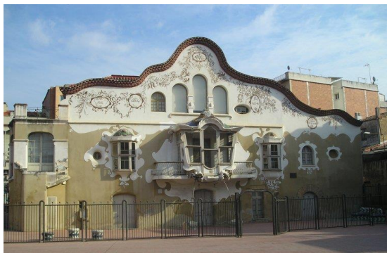
Imagem 124 - Estado da fachada principal antes da intervenção
