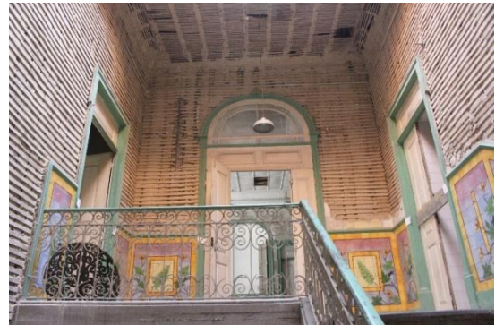
Imagem 74 - Hall superior da escadaria - acesso ao salão secundário (esquerda), salão principal (centro) e instalações sanitárias (direita)
