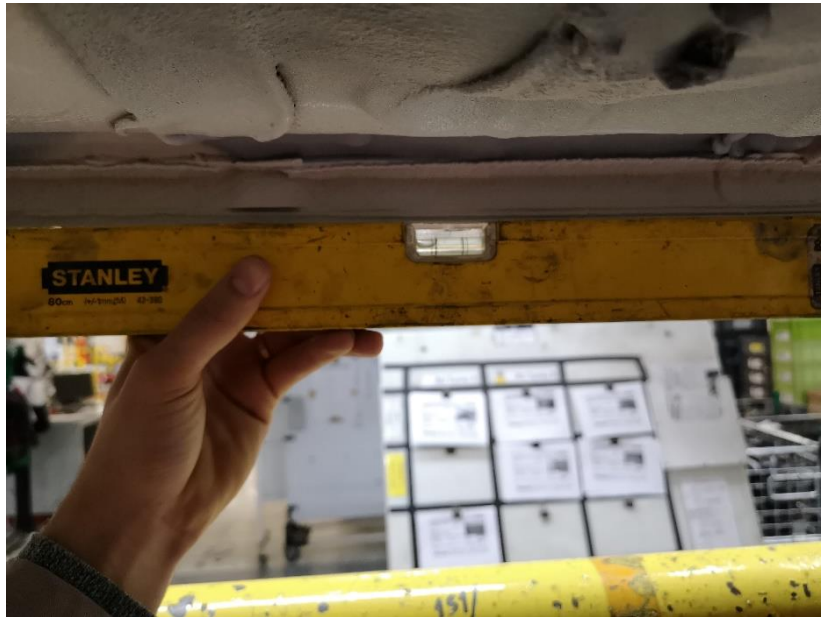
Figura 27 - Medição do Nivelamento na Travessa Lateral
