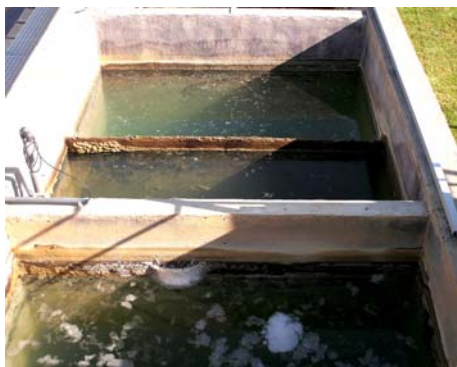
Figura 2.6 – Exemplo de uma câmara de mistura, processo de floculação – ETA da Capinha
