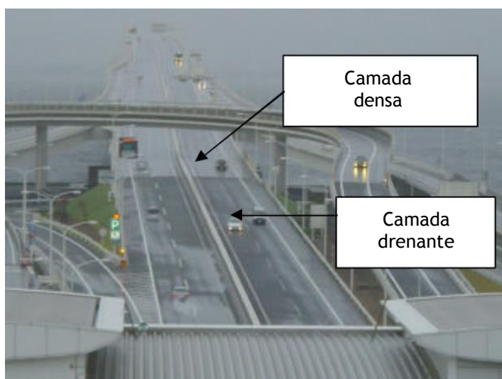
Figura 2.9 - Linha de água perceptível durante período chuvoso na Tokyo Bay , Japão (adaptado de Poulidakos et al. , 2004)
