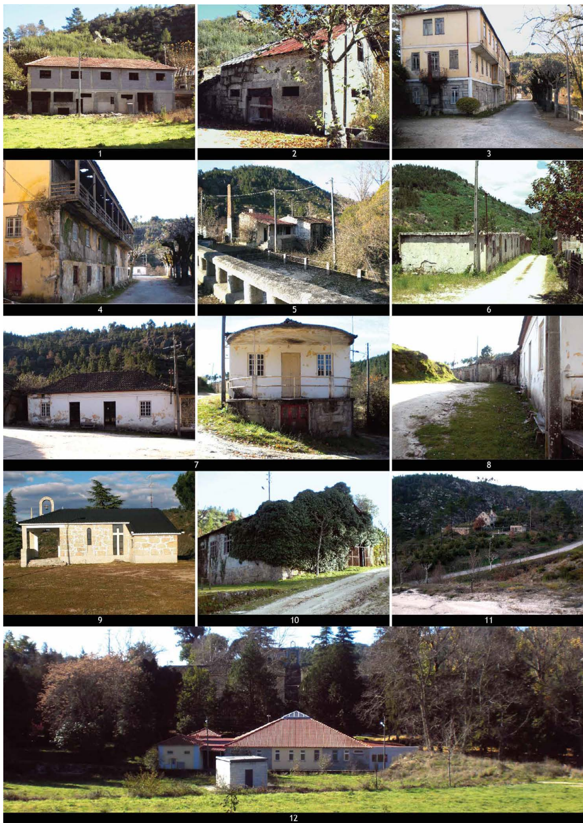
Figura 37 - Conjunto de fotografias das construções existentes.
