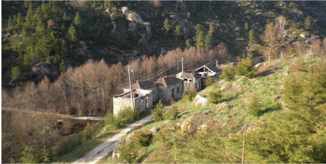
Figura 38 - Conjunto das casinhas em ruínas; local da proposta de alojamentos.
