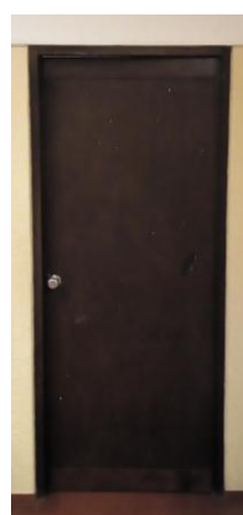
Figura 4.2.1.10 - - Porta Interior em Madeira
