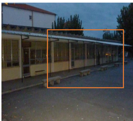
Figura 4.2.5.2 - Exterior da Sala A26
