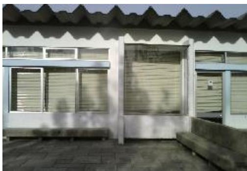
Fig.5.9.1 - Identificação da fachada sala A5
