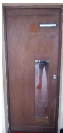
Figura 4.2.3.8 - Porta interior incluindo envidraçado
