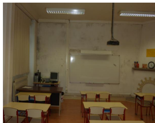
Figura 4.4.1.14 - Interior da sala R5
