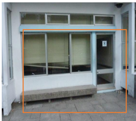
Figura 4.2.4.2 - Exterior da sala A8
