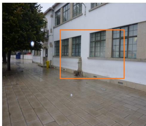
Figura 4.4.1.2 - Exterior da sala R1A
