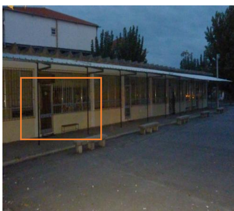
Figura 4.2.6.2 - Exterior da Sala A25
