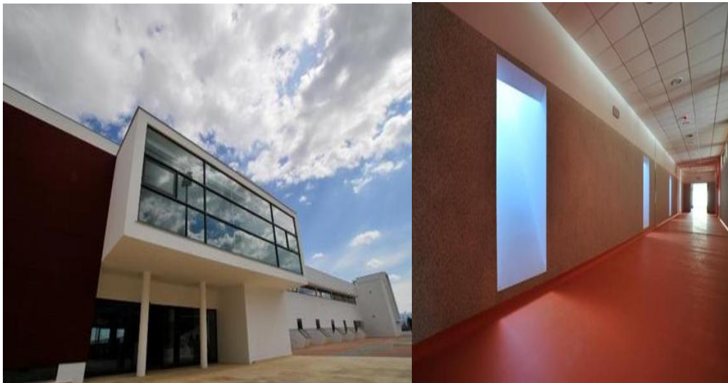
Figura 4.2.1.8 - Escola Internacional da Covilhã, Covilhã - Edificação Nova
