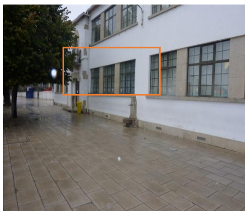
Figura 4.4.1.11 - Exterior da sala R1A
