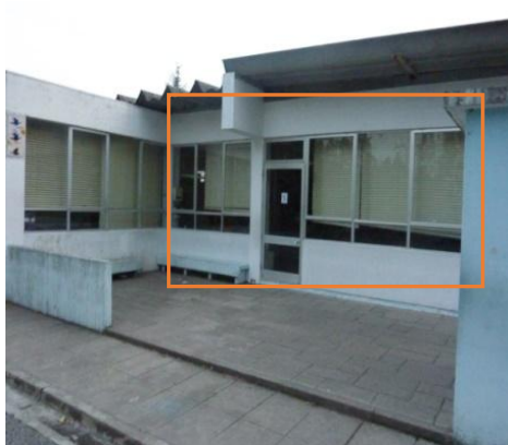
Figura 4.2.2.2 - Exterior da sala A5
