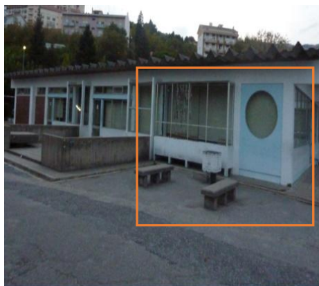
Figura 4.2.3.2 - Exterior da Sala A6
