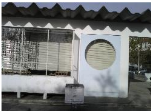
Fig.5.9.3 - Identificação da fachada sala A6
