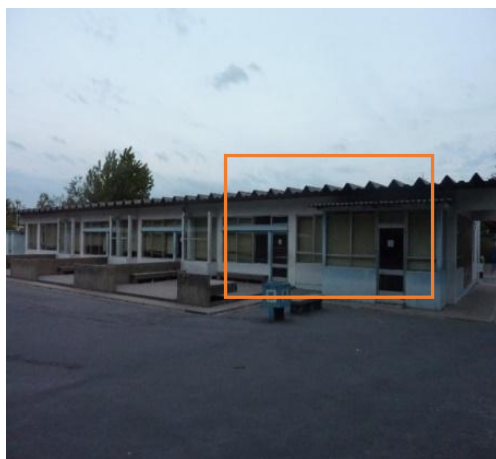
Figura 4.2.1.3 - Exterior da Sala A1
