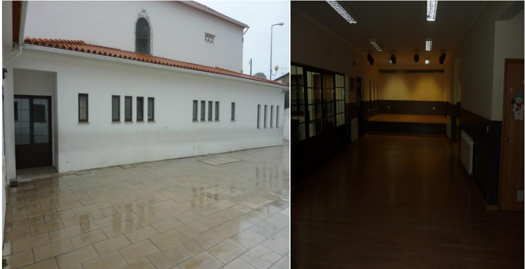
Figura 4.2.1.7 : Escola do Rodrigo, Covilhã - Criação de um Sala multiusos contigua ao Edifício Principal
