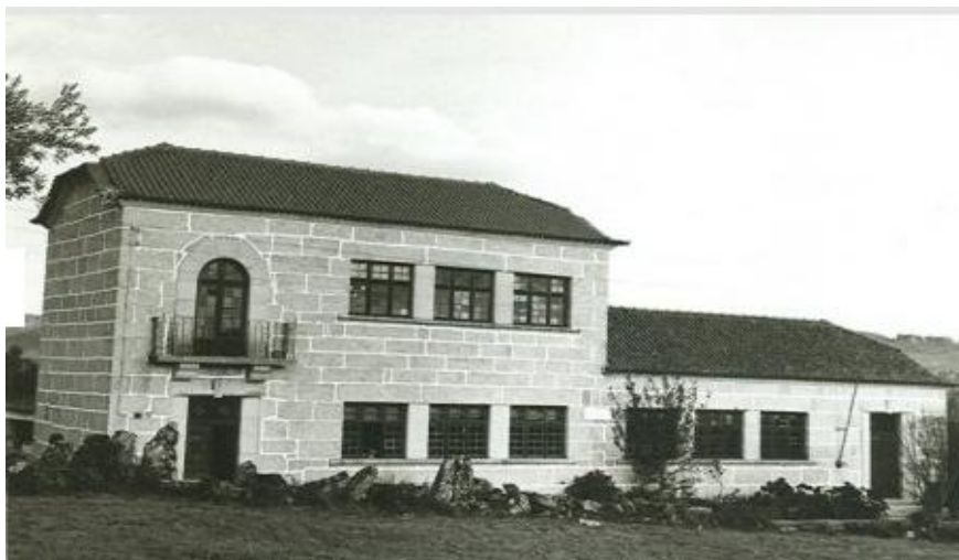
Figura 4.2.1.4 - Escola de Dornelas, Aguiar da Beira, Guarda; Edifício de 3 salas, Tipo Beira Alta Arquivo Direção - Geral do Equipamento Escolar 1973 [3]
