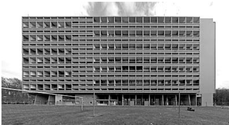
34. Fachada de Unité d'Habitation, Marselha, França, 1949.
