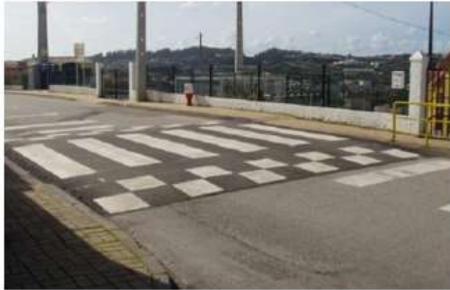
Figura 2.20 - Passagem de peões elevada
