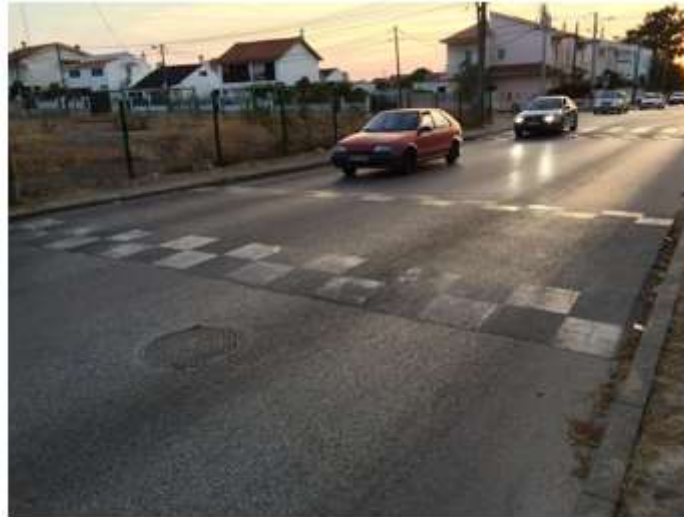
Figura 2.19 - Lomba redutora de velocidade numa zona residencial (Seixal)
