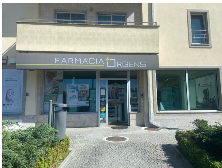
Figura 4- Fachada exterior da FO
