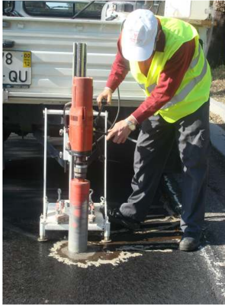
Figura 4. 7: Corte do carote no pavimento, usando uma caroteadora.
