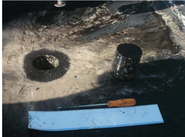
Figura 4. 9: Carote após remoção do pavimento.
