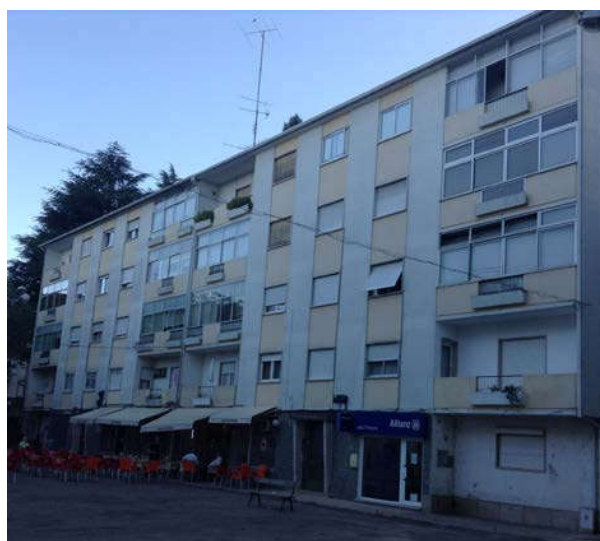
Figura 1 – Fachada principal do edifício em estudo
