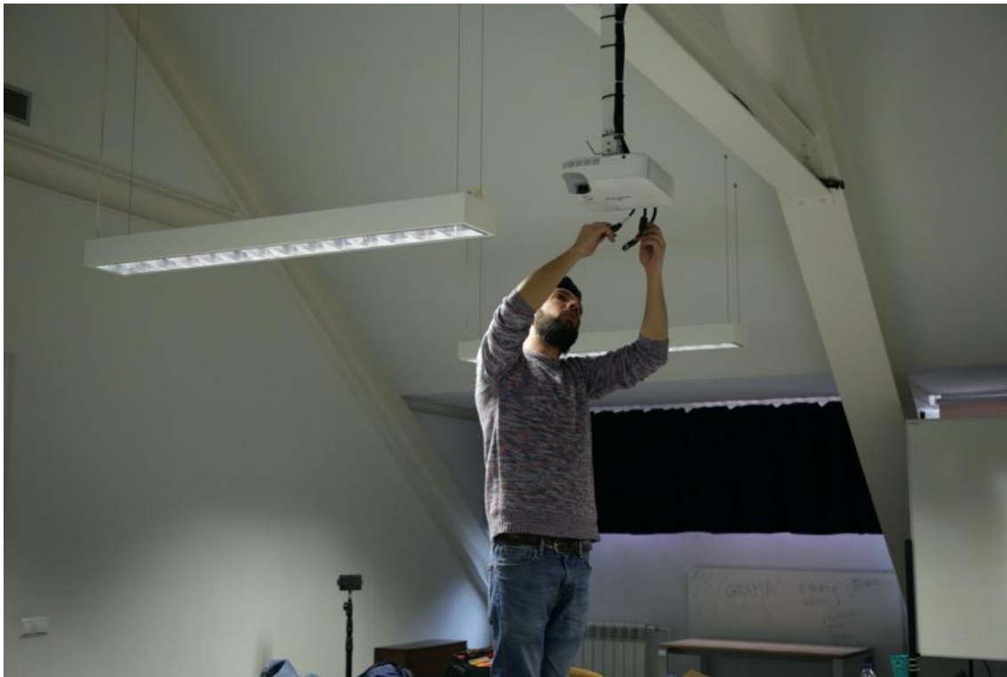
Figura 86 - Montagens Retro Instalação
