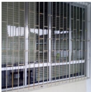
Figura 4.2.5.8 - Gradeamento exterior metálico
