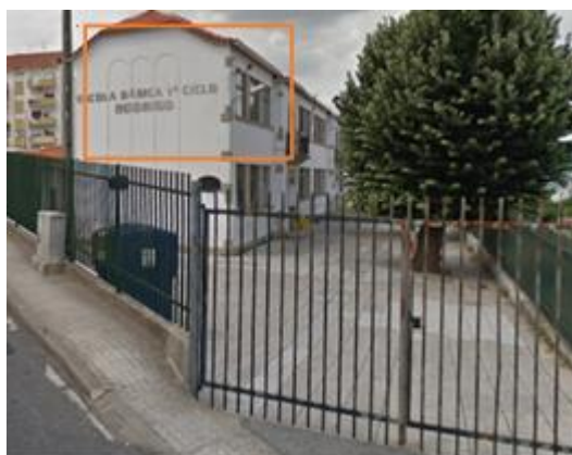
Figura 4.4.3.2 - Exterior da sala 5
