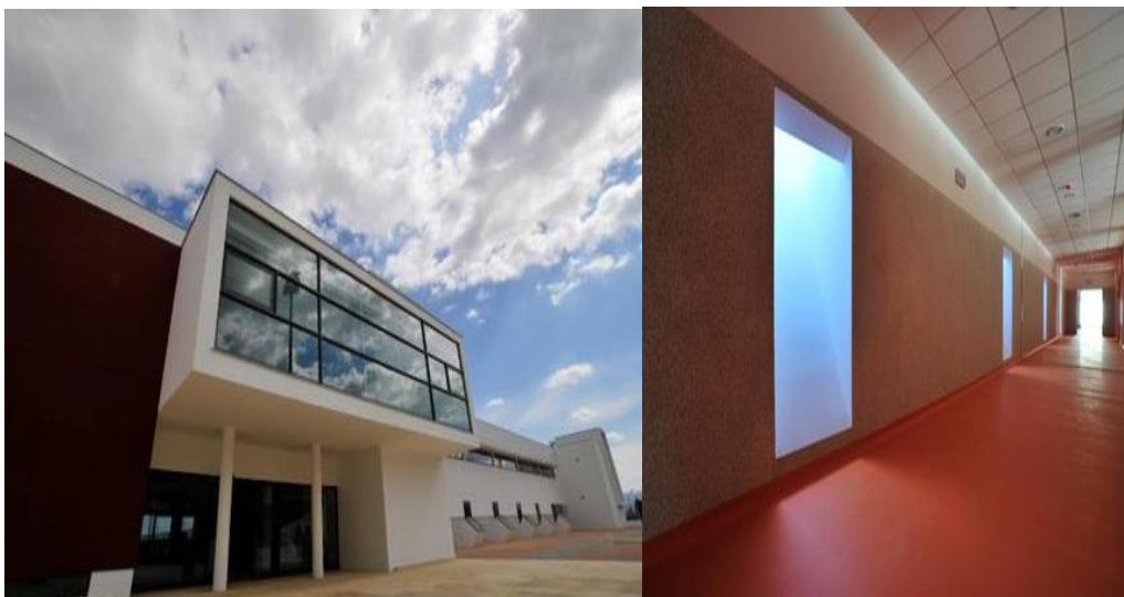
Figura 1.1.6 - Escola Internacional da Covilhã, Covilhã - Edificação Nova
