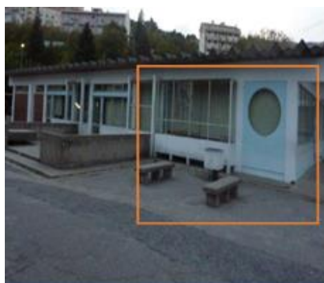
Figura 4.2.3.2 - Exterior da Sala A6
