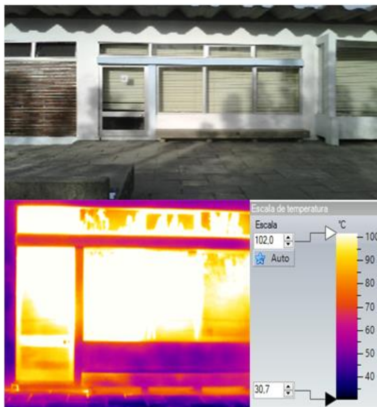
Figura 3.9.1 - Representação do programa utilizado Testo para tratamento de dados termográficos
