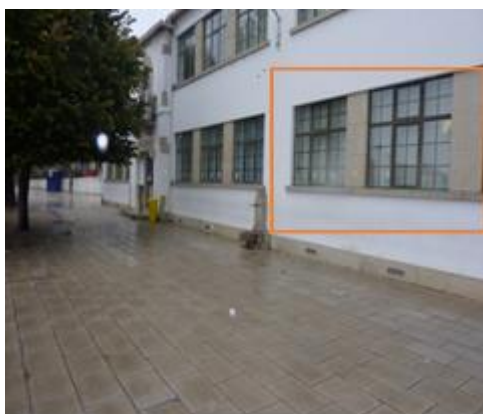
Figura 4.4.1.2 - Exterior da sala R1A
