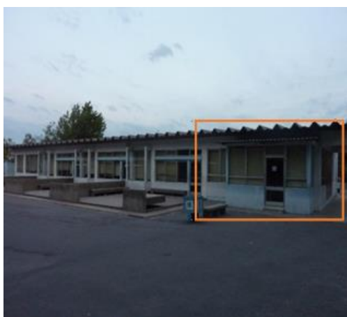
Figura 4.2.1.2 - Exterior da Sala A1
