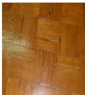
Figura 4.3.1.9 - Parquê em madeira
