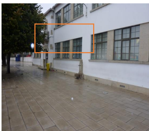
Figura 4.4.2.2 - Exterior da sala R1A
