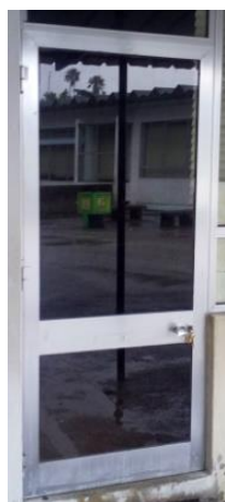
Figura 4.2.1.10 - Porta exterior em alumínio
