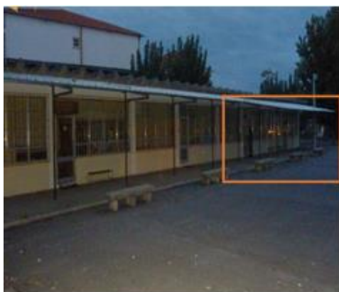
Figura 4.2.6.2 - Exterior da Sala A25
