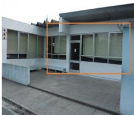
Figura 4.2.2.2 - Exterior da sala A5
