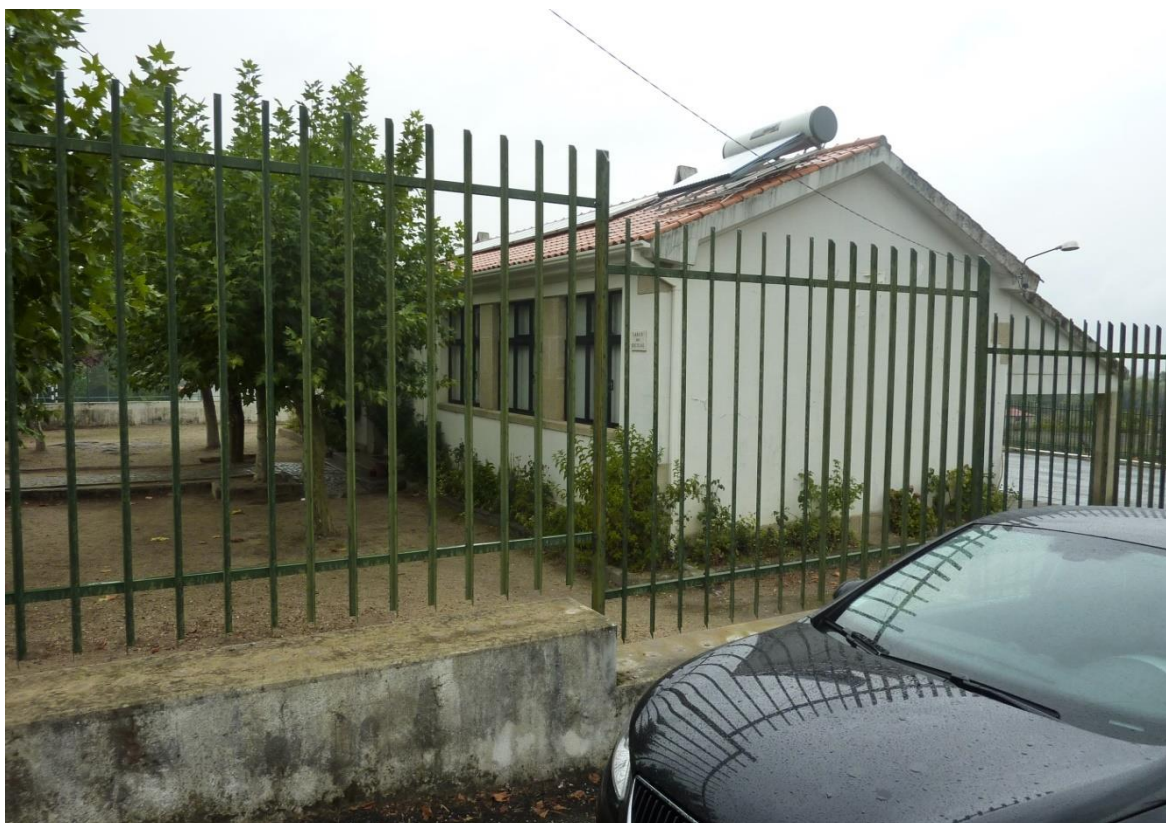
Figura 1.1.4 - Escola Peraboa, Covilhã - Utilização de Painéis Solares
