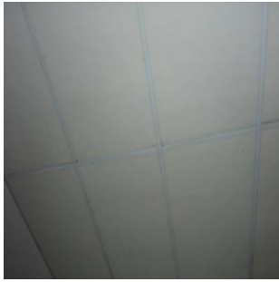
Figura 4.2.5.6 - Placas de lã de rocha
