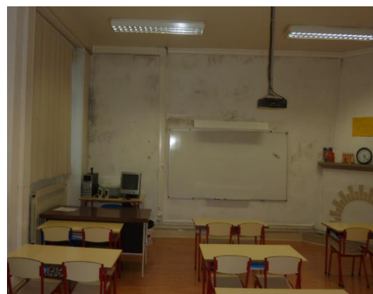
Figura 4.4.3.3 - Interior da sala 5
