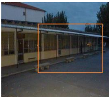
Figura 4.2.5.2 - Exterior da Sala A26
