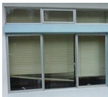
Figura 4.2.1.7 - Janelas em alumínio exteriores
