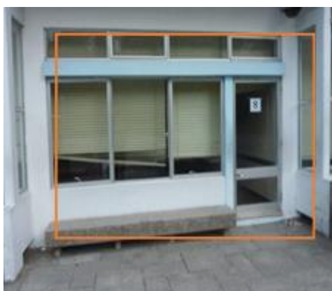
Figura 4.2.4.2 - Exterior da sala A8
