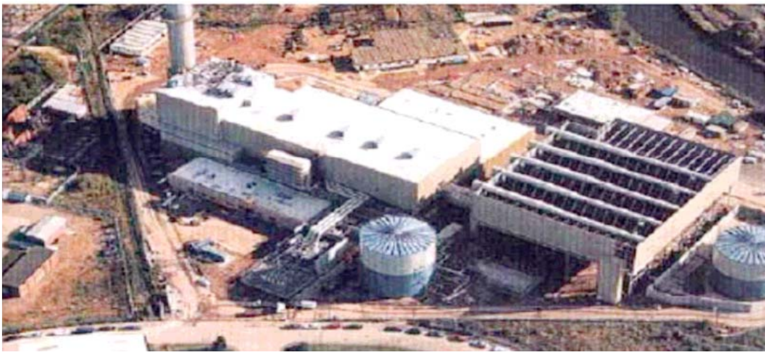
Fig. 2.25 – Ilustração de uma instalação industrial com sistema em ciclo combinado, uma turbina a gás e uma turbina a vapor, com sistema de condensação na zona à direita, RU-Reino Unido (imagem extraída de [2]).
