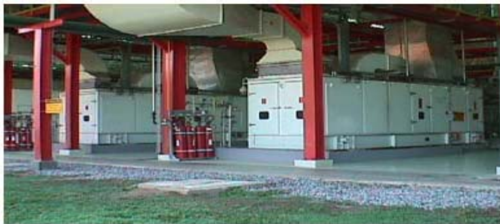
Fig. 2.18 – Ilustração de um sistema de turbinas a gás, fábrica de cerveja Brahma - Brasil) (imagem extraída de [2]).
