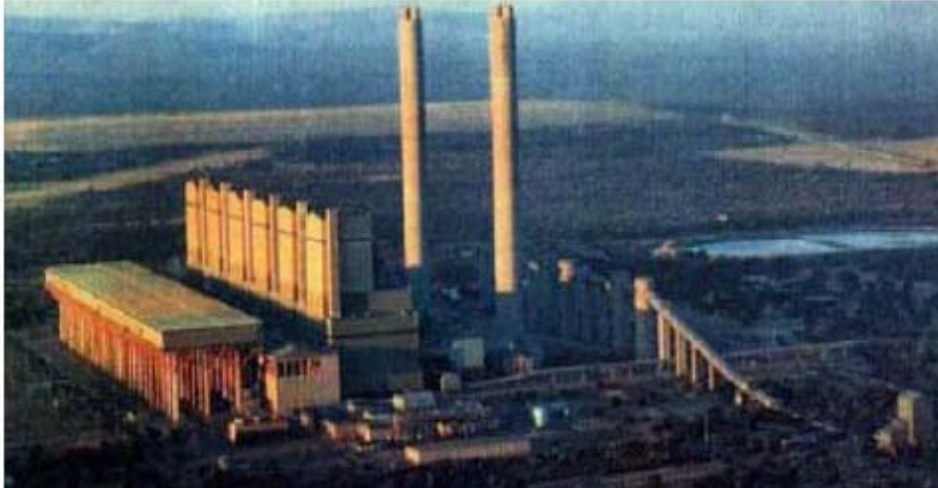
Fig. 2.22 – Ilustração de uma instalação industrial onde se usa turbinas a vapor, de notar à esquerda caldeira de condensação, uma das maiores do mundo, Matimba, África do Sul. (imagem extraída de [2]).
