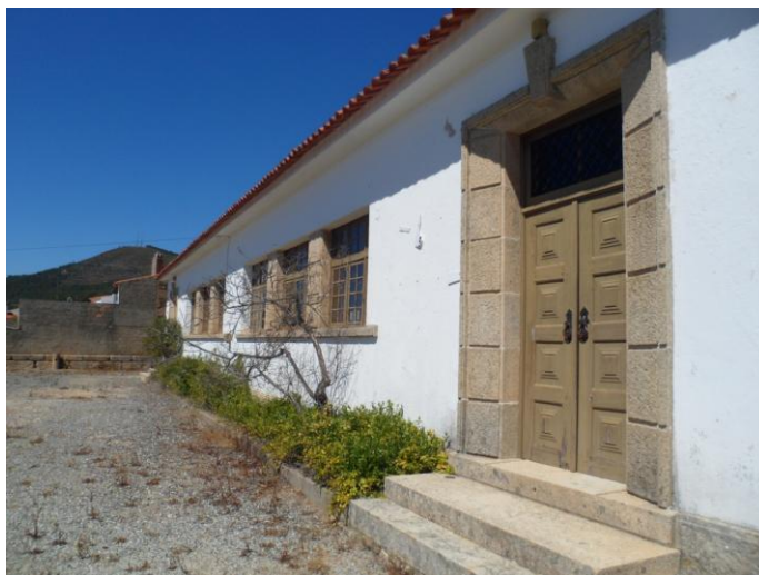
Figura 51 - Alteração de simplificação , cantaria de porta, Tipo Serra , escola de Monte Leal.
