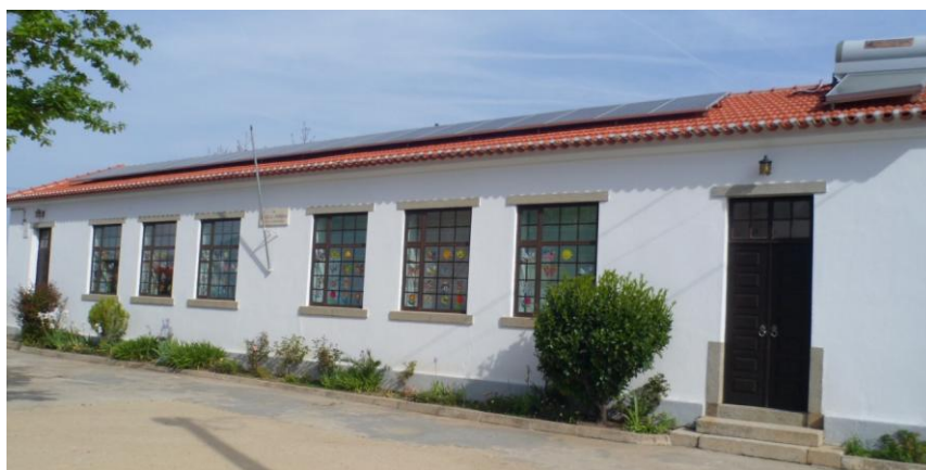
Figura 59 - Características da fachada principal da escola de Aldeia de Joanes, que não correspondem nem ao Tipo Beira Alta nem ao Tipo Serra .
