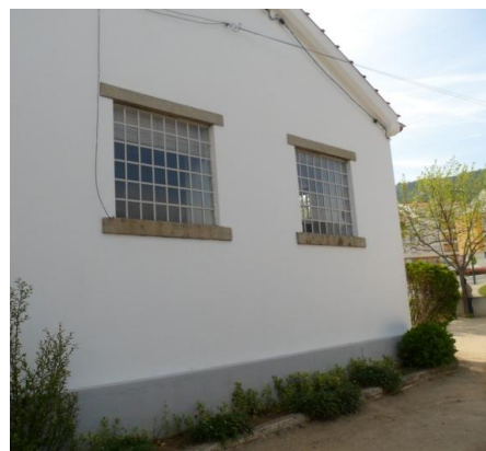
Figura 61 - Vãos envidraçados nas laterais do edifício, não correspondem a nenhuma tipologia aplicada na região centro.
