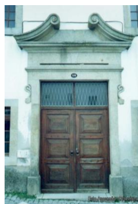
Figura 63 - Cantaria granítica da porta de entrada da escola de Pêro Viseu.
