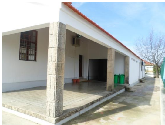
Figura 60 - Pilares revestidos a cantaria granítica, são características do Tipo Beira Alta e Tipo Serra .
