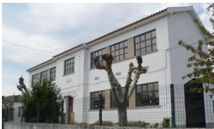
Figura 58 - Caraterísticas da fachada principal da escola de Silvares. Tipo Beira Alta ao nível do rés-do-chão e janela do Tipo Urbano ao nível do piso superior.
