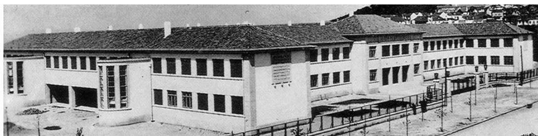
Figura 7 - Liceu Nuno Alvares, arquiteto José Costa e Silva, Castelo Branco. Projeto do Plano 38 , estilo oficial português suave .
