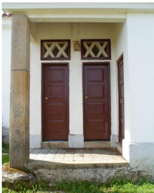
Figura 53 - Pilar em cantaria granítica presente no recreio coberto, escola Tipo Rural de Freixial.
