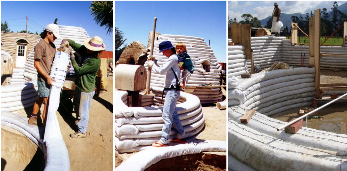
Figura 65. Processo Construtivo “Superadobe”
