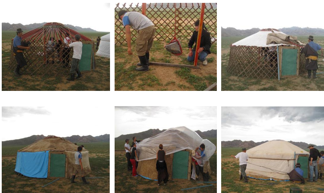
Figura 79. Processo de Montagem do Ger
