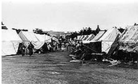
Figura 18. Habitações Temporárias Tóquio, Japão (1923)
