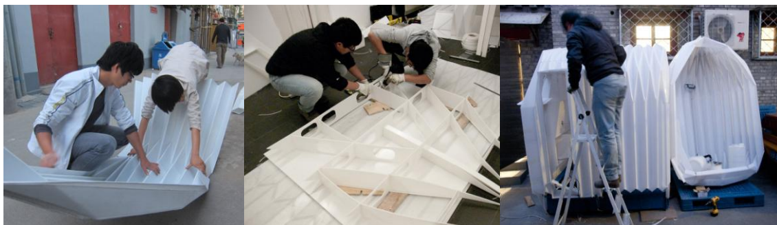
Figura 87. Processo de Construção da Casa Triciclo
